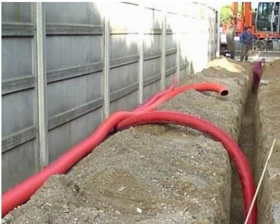
Figura 6 - scavo per elettrodotti interrati
