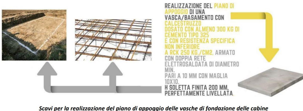
Figura 4 - platea fondazione per cabine prefabbricate
