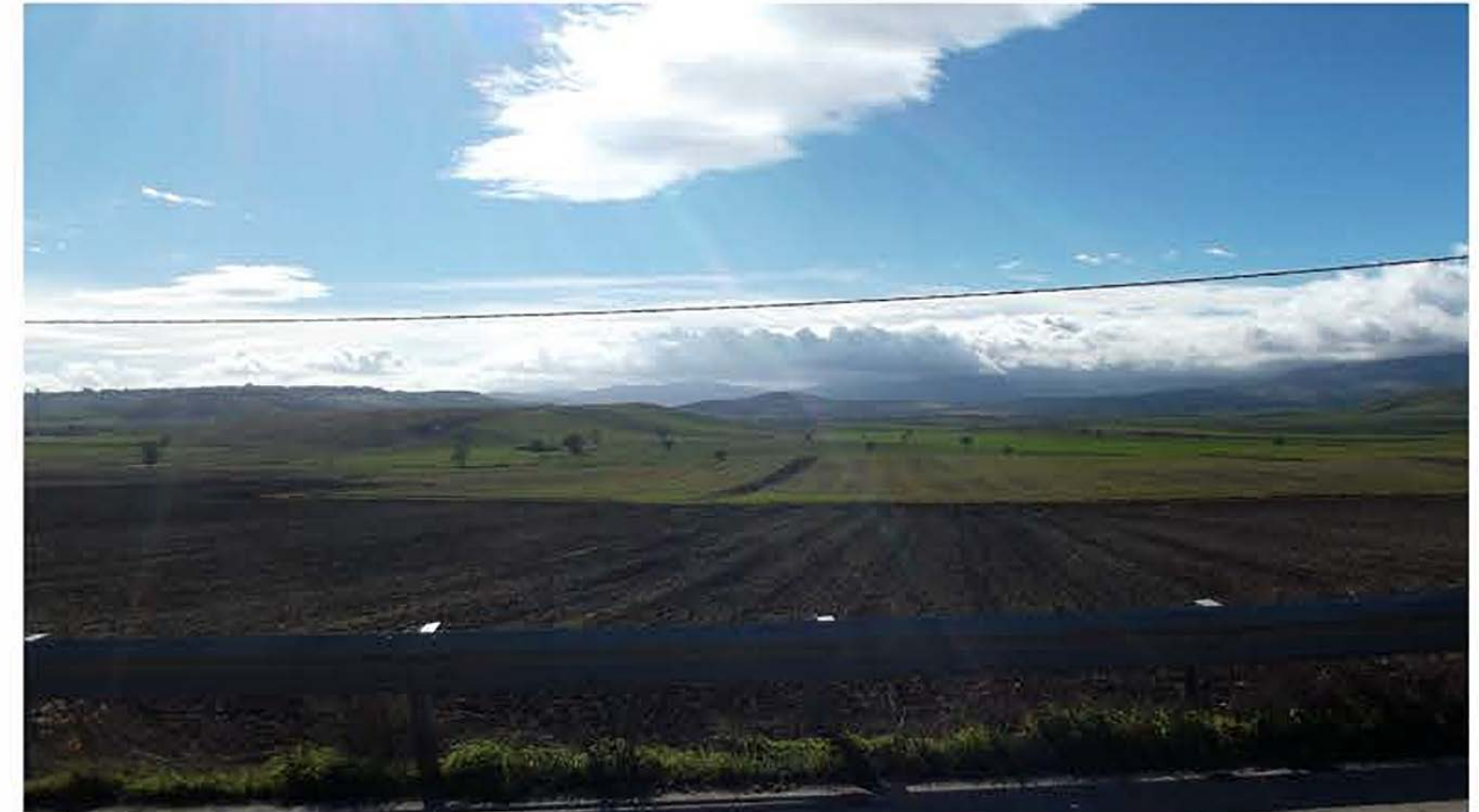
VISTA AREA DI IMPIANTO PLOT 2
