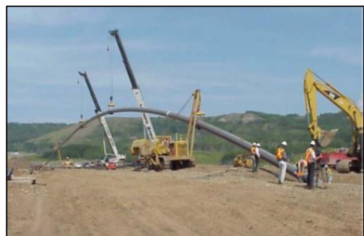
Figura 6-3 – Esempio di operazione di centraggio di tubo
