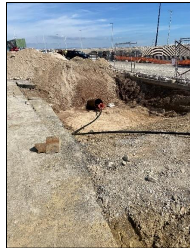
Figura 6-5 – Esempi di installazione del cavo da carosello
