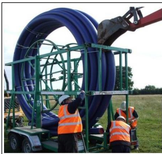
Figura 6-2 – Esempio di tubo-camicia HDPE OD 180 mm x 100 m su carosello
