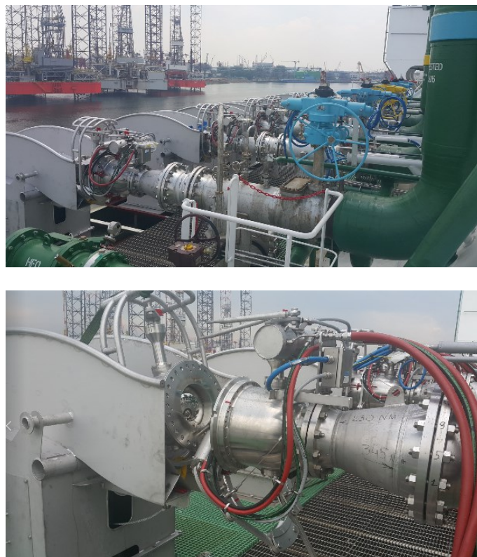
Figura 33 – Dettaglio fotografico tipico di un accoppiamento manichette
