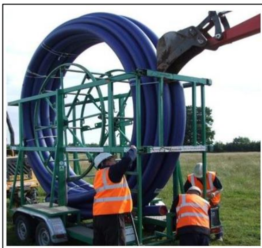
Figura 5-2 – Esempio di tubo-camicia HDPE OD 180 mm x 100 m su carosello
