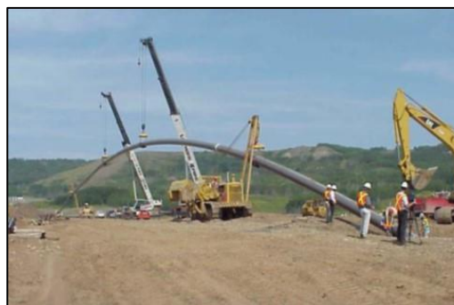
Figura 5-3 – Esempio di operazione di centraggio di tubo
