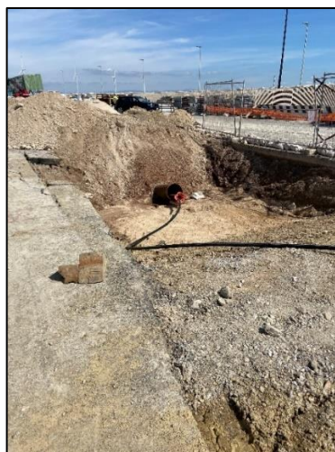
Figura 5-5 – Esempi di installazione del cavo da carosello
