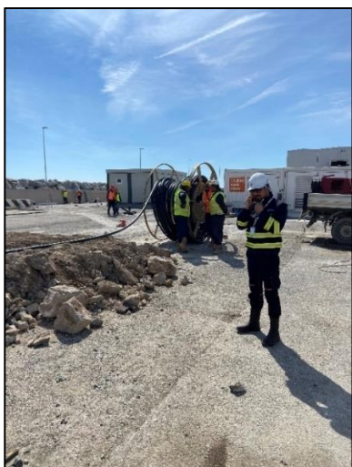
Figura 5-5 – Esempi di installazione del cavo da carosello
