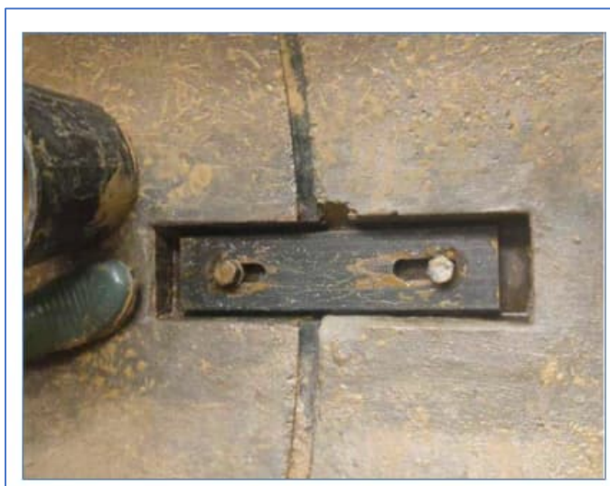
Figura 6-11: Esempio di piastra di connessione
