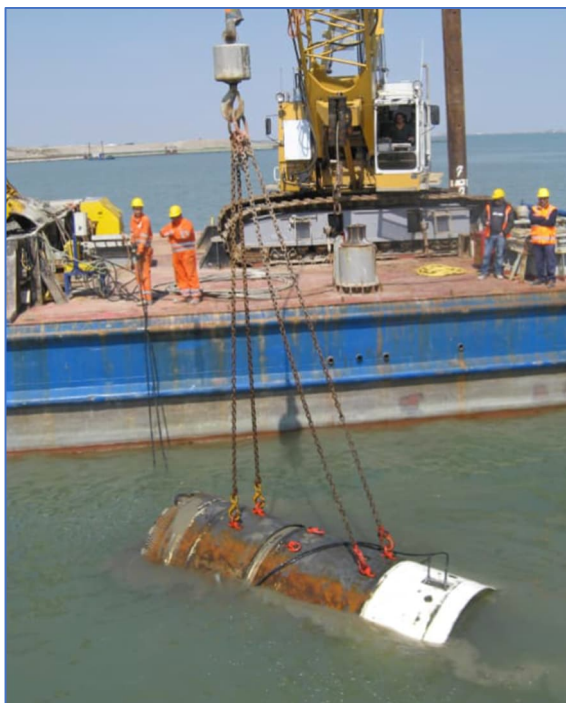
Figura 6-13: Operazione di recupero della MTBM
