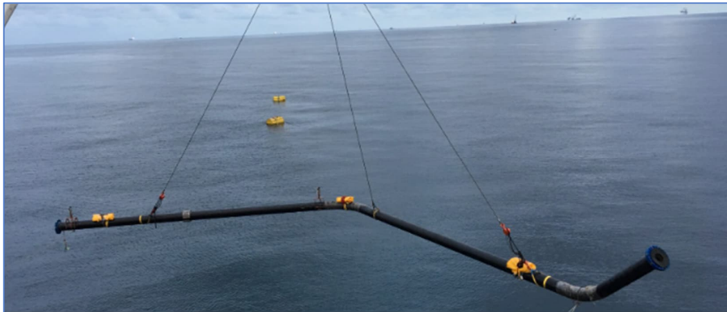
Figura 9-2: Esempio di Sollevamento di un Tie-in Spool
