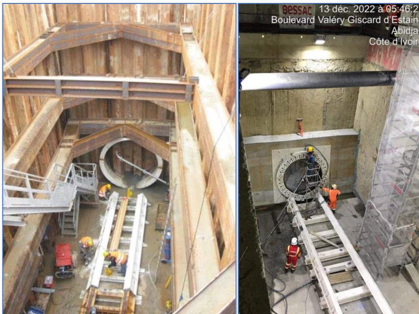
Figura 6-1: Esempio di Pozzo di Spinta Realizzato con Palancole (Sx) e Diaframmi In Cemento Armato (Dx)
