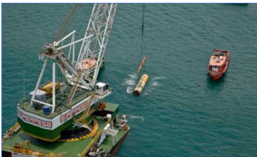
Figura 6-7: Operazioni di Sollevamento e Recupero della MTBM
