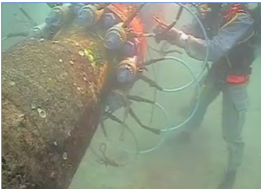
Figura 9-1: Esempio di Connessione Flangiata eseguita con sommozzatori
