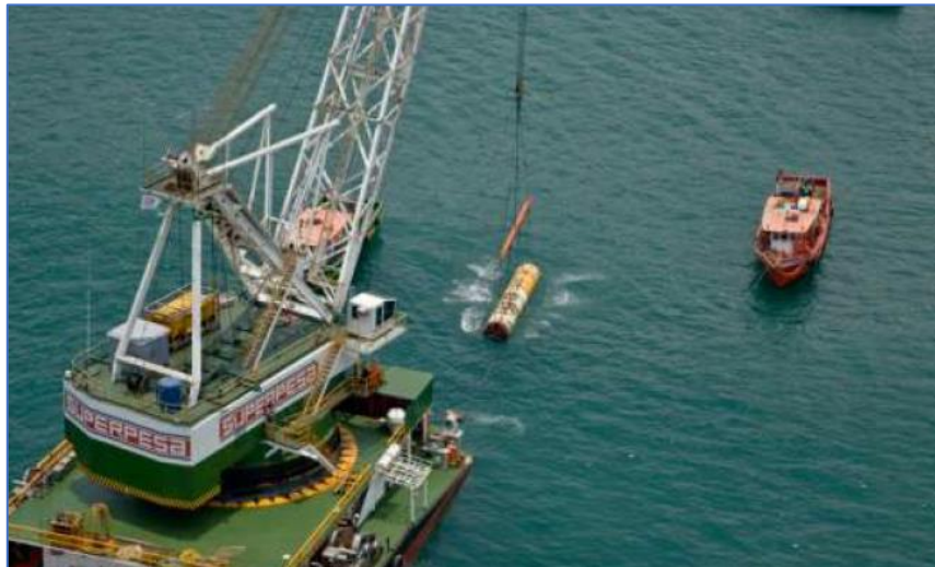
Figura 5.4: Operazione di recupero della MTBM
