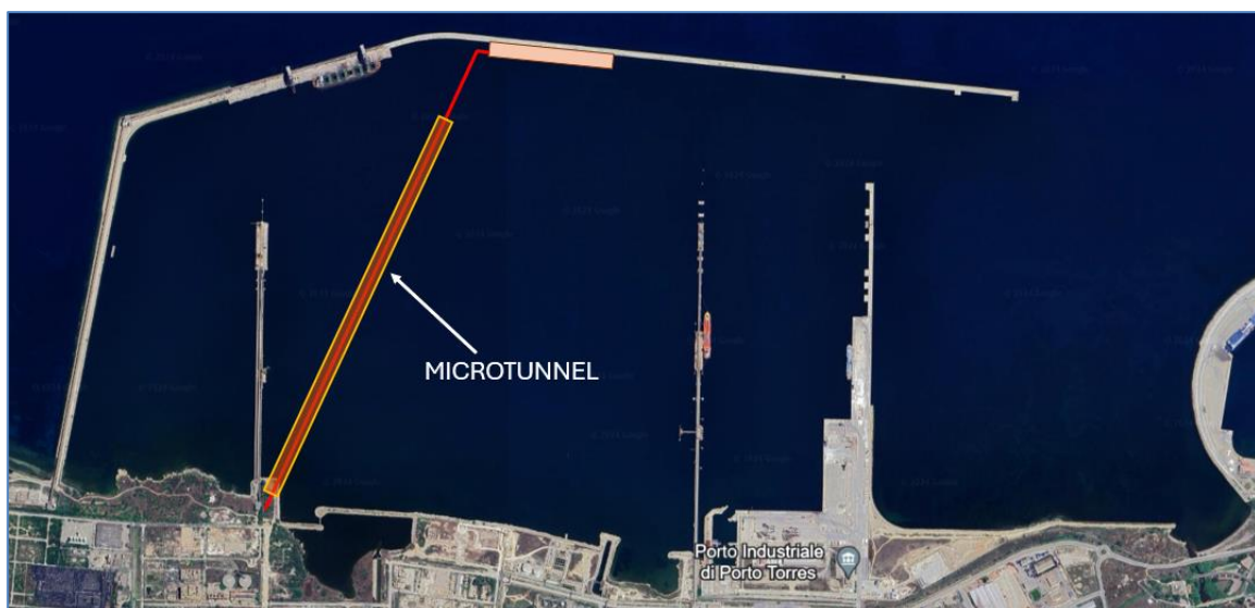
Figura 2.2/B – Attraversamento in Microtunnel – Vista Generale
