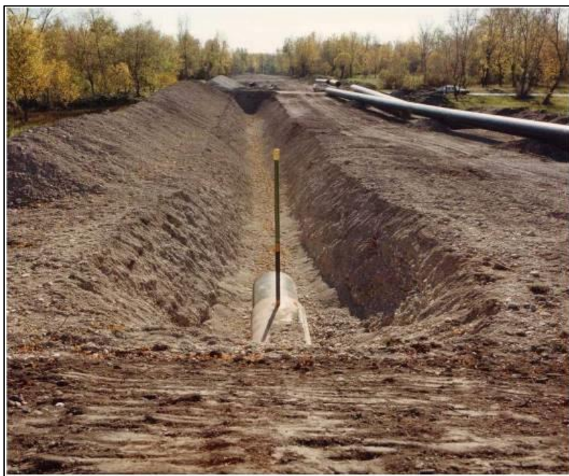
Figura 5.1-10: Attraversamento con spingitubo. Dettaglio sullo sfiato
