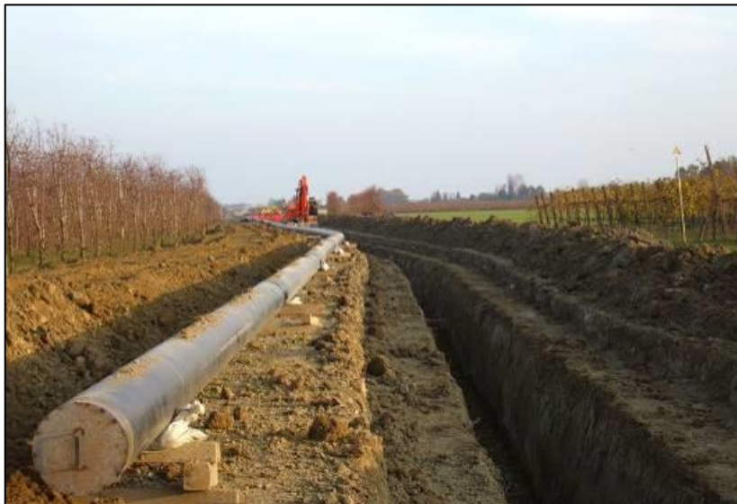
Figura 5.1-5: Scavo della trincea
