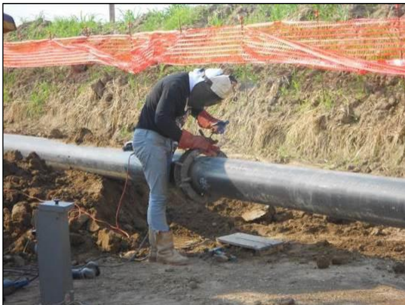
Figura 5.1-3: Saldatura delle tubazioni
