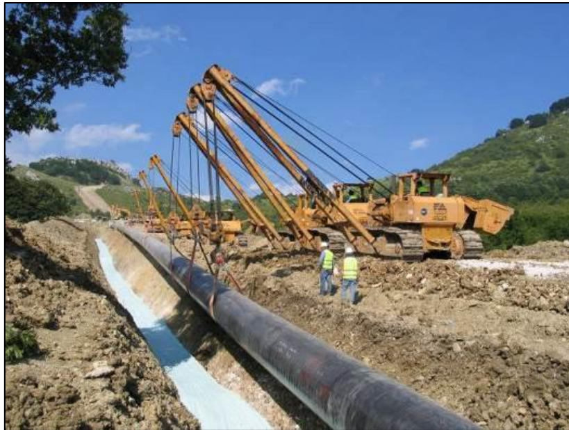
Figura 5.1-7: Posa della condotta
