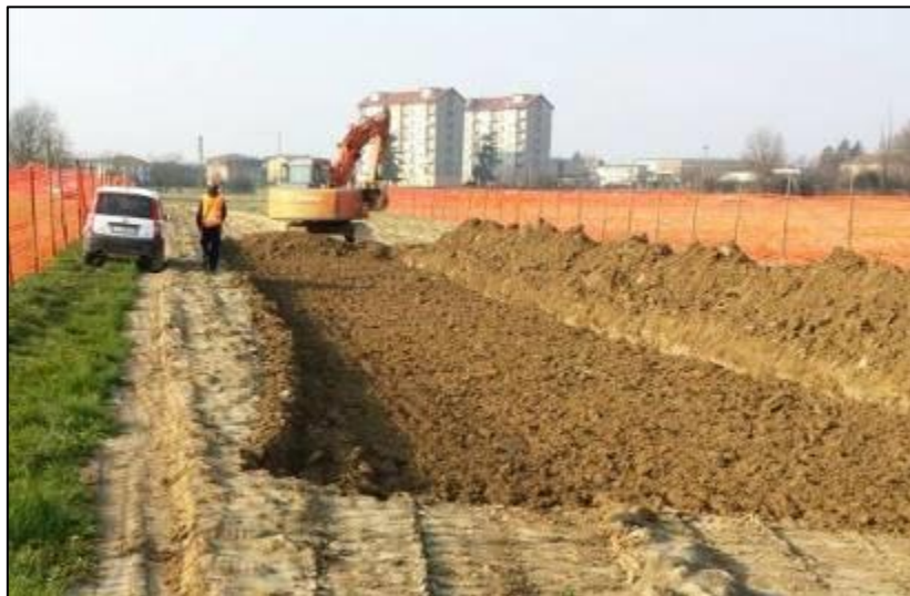
Figura 5.1-1: Apertura della pista di lavoro
