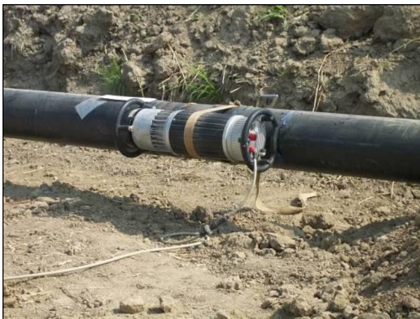
Figura 5.1-4: Controlli non distruttivi delle saldature
