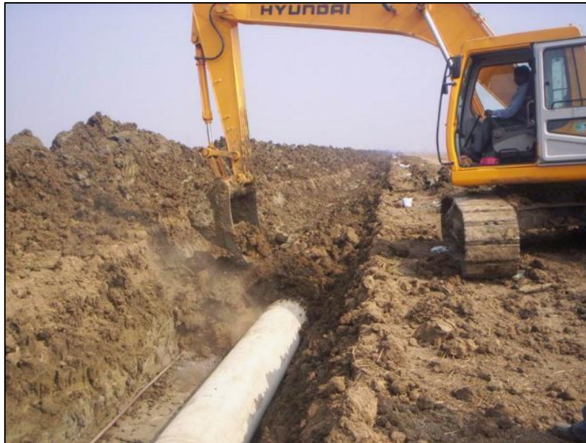
Figura 5.1-8: Rinterro della condotta
