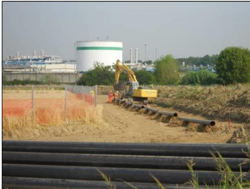
Figura 5.1-2: Sfilamento tubi
