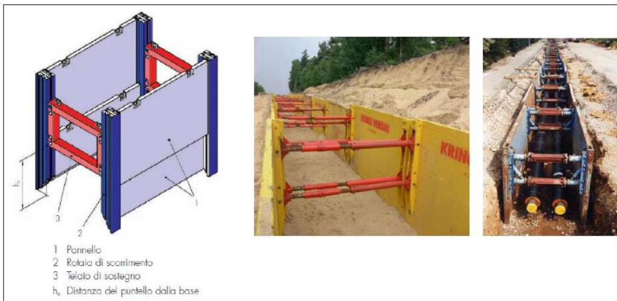
Figura 2-4 Opere provvisorie - sbadacchiature con legname e sistemi di puntellazione per scavi
