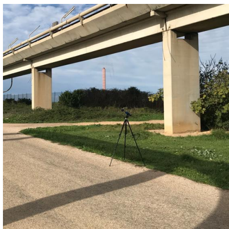
Figura 6-A Punto di misura REC01 Vista Nord-Ovest
