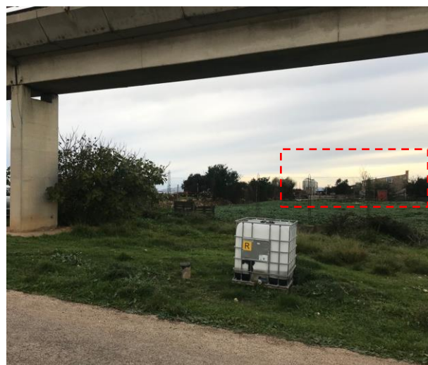
Figura 6-D Punto di misura REC01 Vista Nord
