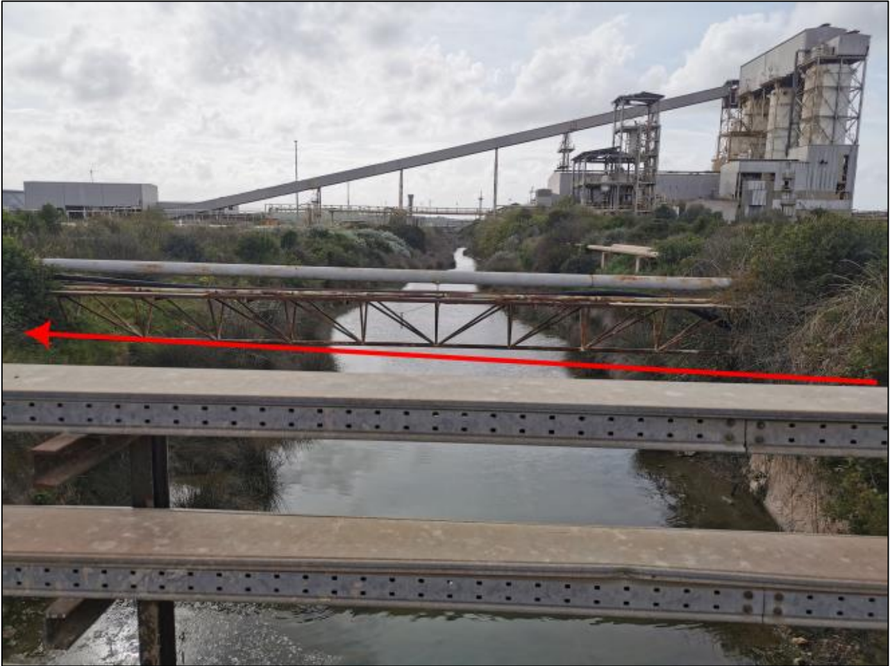
Figura 5.11-7: Paesaggio industriale degli impianti e delle reti in corrispondenza dell'attraversamento in trenchless del canale. Il tracciato è indicato con la linea rossa
