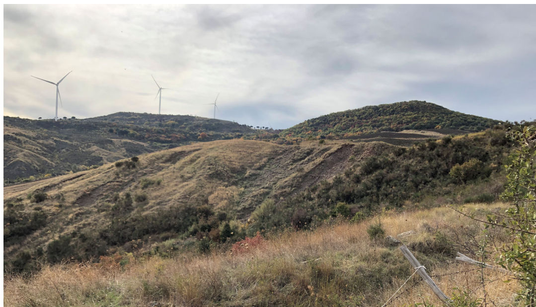
Foto 4-1 – Fenomeni di scivolamento agenti sul versante su cui si imposterà il Viadotto Cerro
