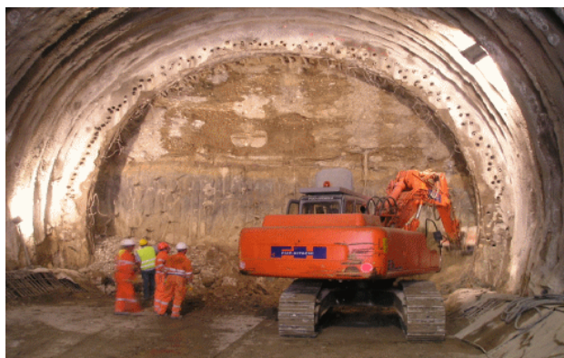
Scavo e smarino della galleria
