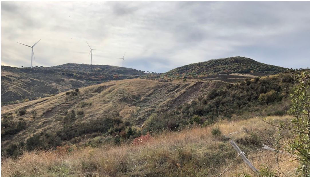
Foto 3-2 – Fenomeni di scivolamento agenti sul versante su cui si imposterà il Viadotto Cerro
