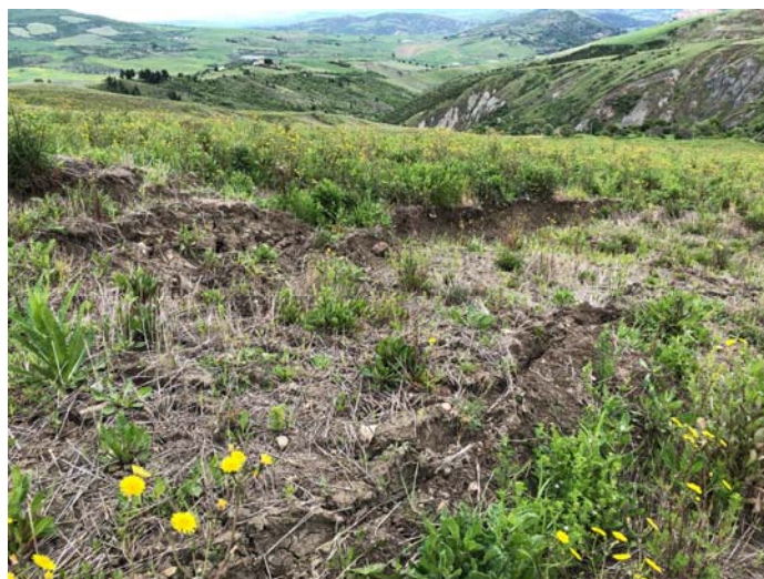
Foto 3-7 – Fenomeno franoso attivo riscontrato in corrispondenza del versante posto all’imbocco Nord della Galleria Naturale, e sul quale si impostano le alternative 2-3 e 3.1(pk 7+180 circa).
