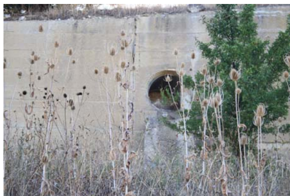
Foto 3-15 – Immagine del muro di contenimento della strada comunale esistente con presenza di un evidente “rotazione” del III concio verso valle per circa 10 cm, a dimostrazione di un dissesto in atto agente sul versante.
