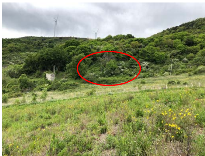
Foto 2-18 – Area di imbocco nord (cerchiata in rosso) della Galleria naturale Valico Pazzano impostata nei depositi flyshoidi del FYR
