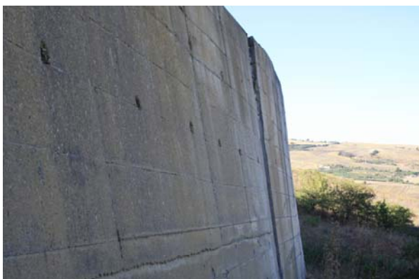
Foto 3-15 – Immagine del muro di contenimento della strada comunale esistente con presenza di un evidente “rotazione” del III concio verso valle per circa 10 cm, a dimostrazione di un dissesto in atto agente sul versante.
