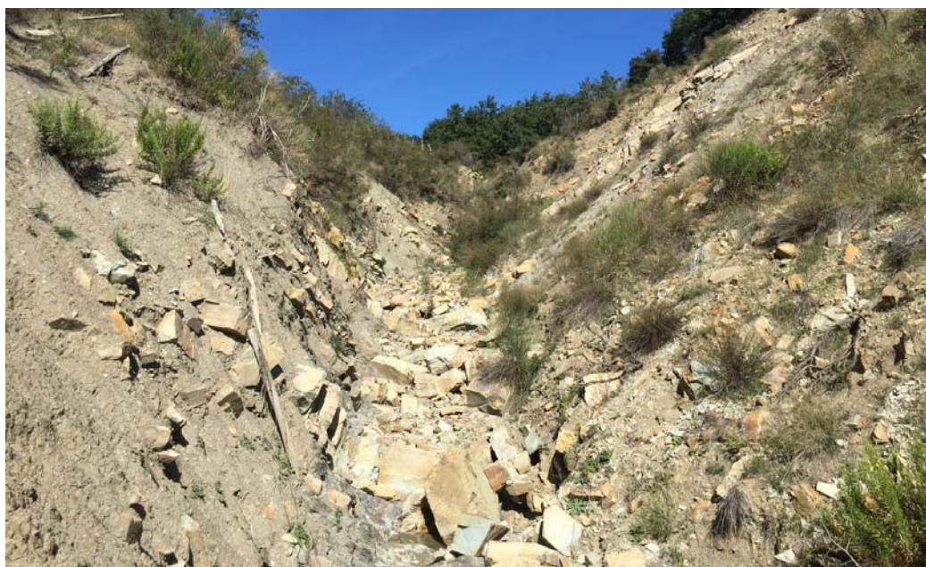
Foto 3-3 - Vallone degli Zingari, il cui attraversamento da parte delle alternative 1.1 e 1.2 (km 4+300) è previsto in viadotto
