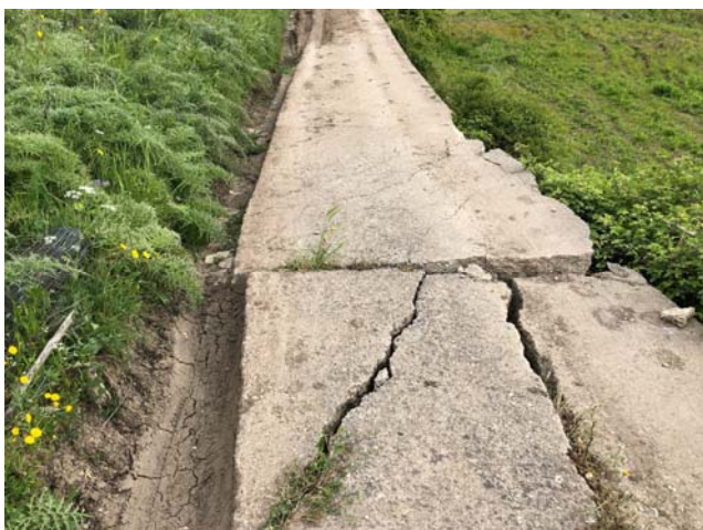
Foto 3-13 – Disarticolazione del corpo della paratia posta esistente ubicata a protezione della strada ad indicare l'attività del movimento franoso considerato.
