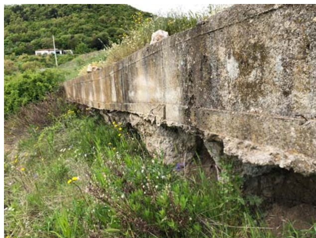
Foto 3-13 – Disarticolazione del corpo della paratia posta esistente ubicata a protezione della strada ad indicare l'attività del movimento franoso considerato.
