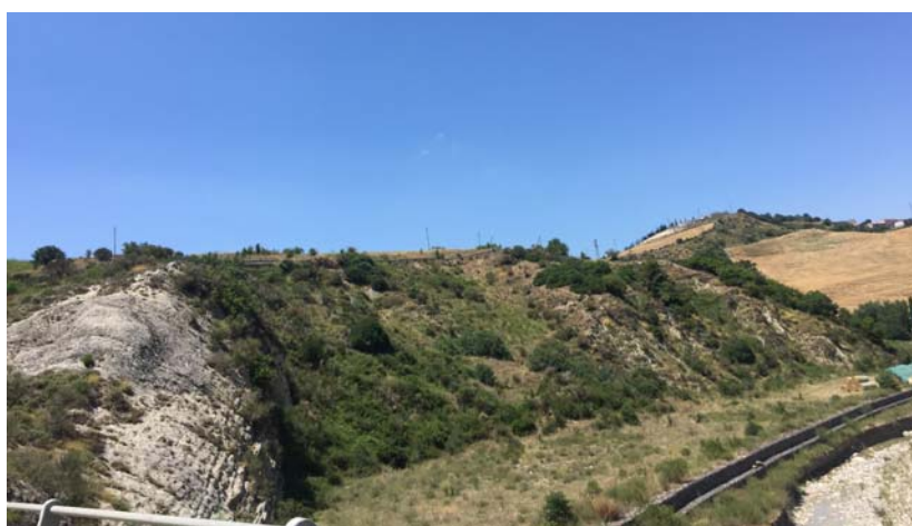
Foto 3-8 – Versante posto in sinistra idraulica del T. Fiumarella del Bosco con fenomeni di scivolamento riconosciuti come quiescenti ed interferenti con l’Alternativa 1.
