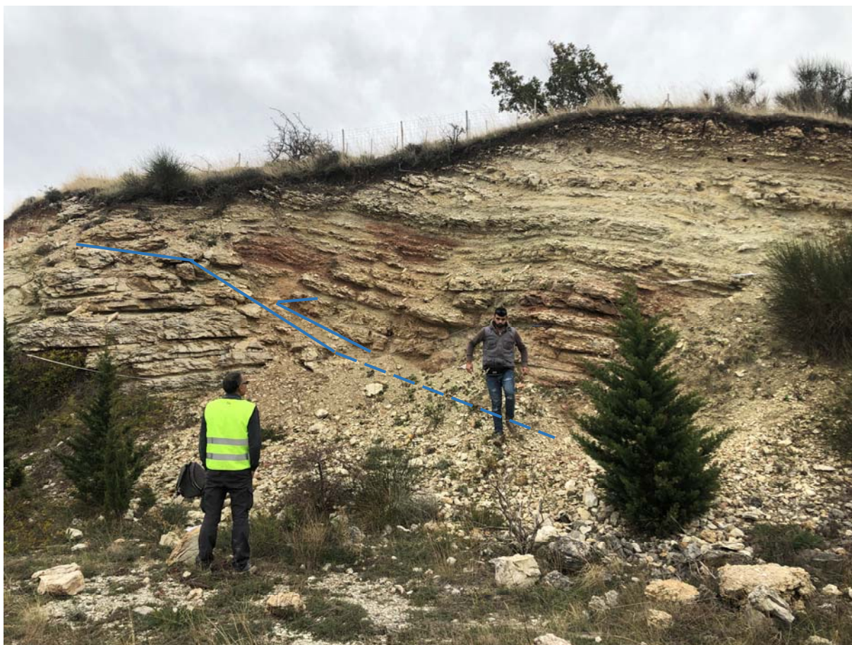
Foto 8-1 – Sovrascorrimento visibile in corrispondenza di un taglio stradale e prossimo al tracciato con riferimento alla Galleria Naturale Valico Pazzano. Si nota il contatto tettonico con il litotipo FYG che sovrascorre rispetto alla facies flyshoide calcareo-clastica del FYR (FYRa)
