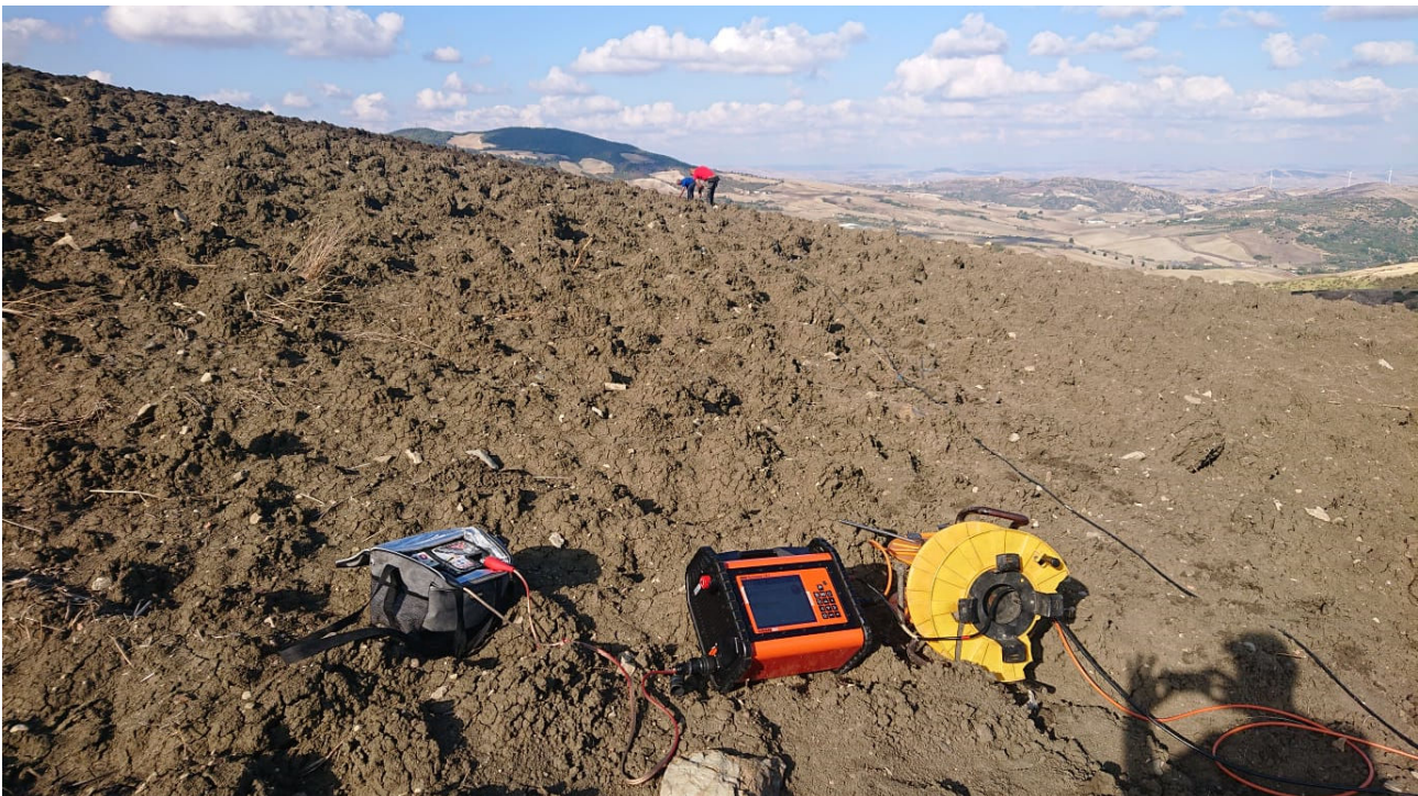
Acquisizione dati profilo geoelettrico TE03
