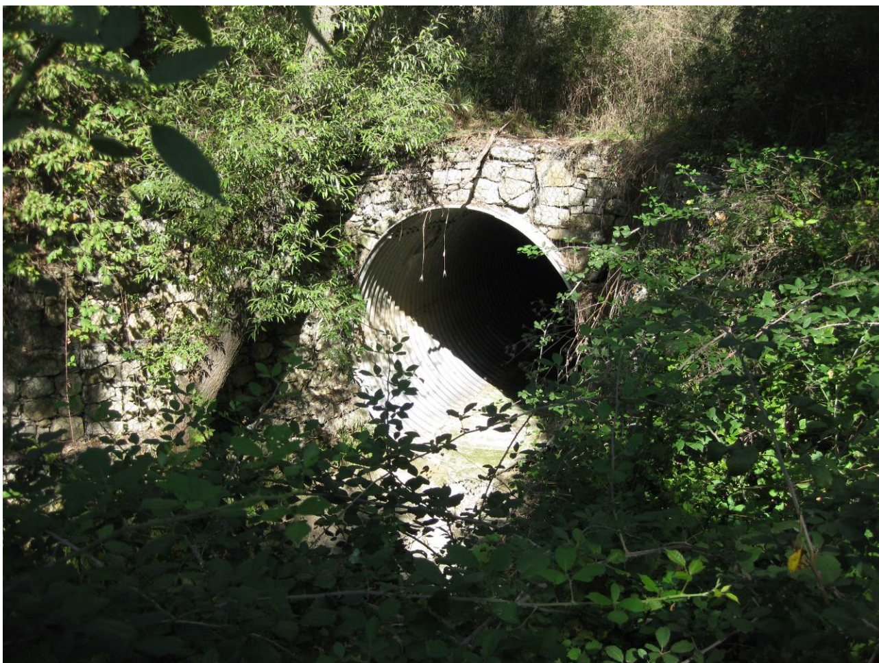
Figura 2.3 – Fosso Rummolo – Attraversamento viabilità comunale a monte dell'intervento in progetto
