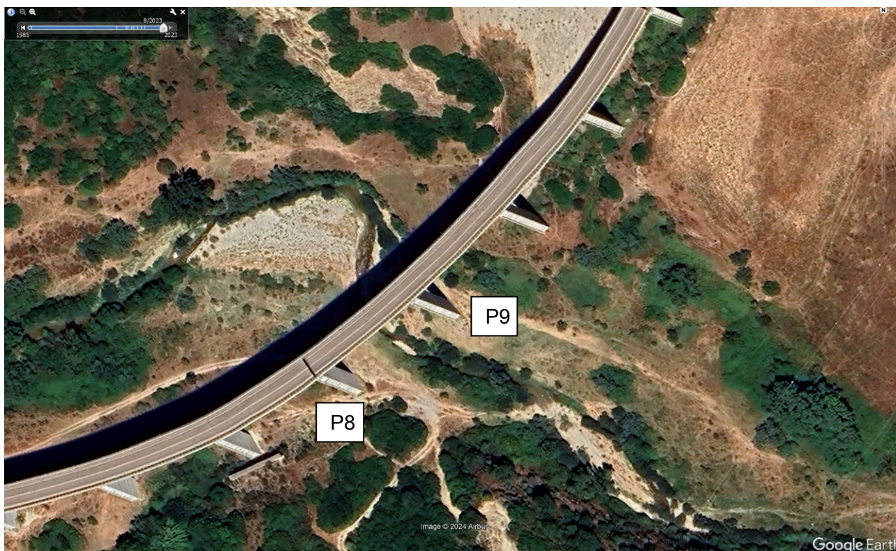
Figura 6.9 : viadotto Torrente Alvo – foto aerea
