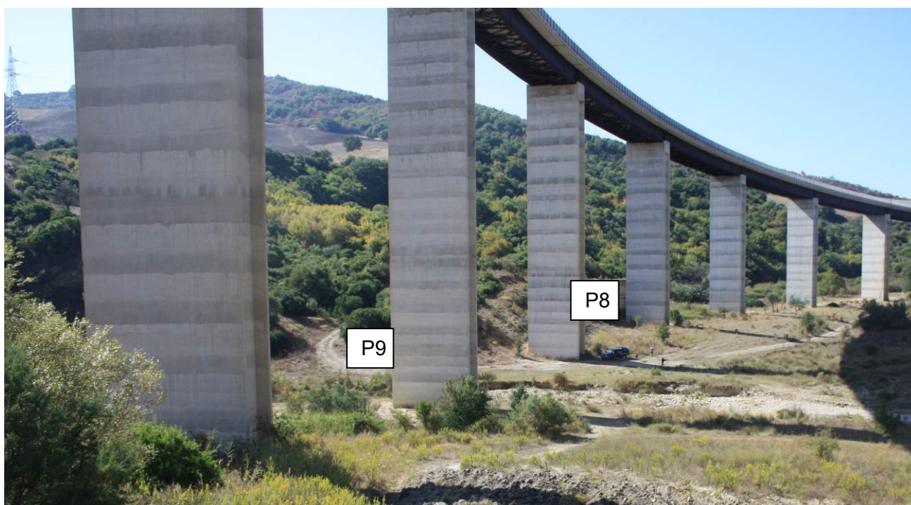
Figura 6.8 : viadotto Torrente Alvo
