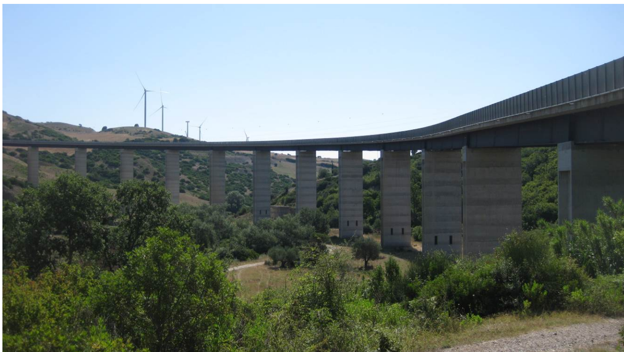
Figura 2.7 – Viadotto di attraversamento del Torrente Alvo
