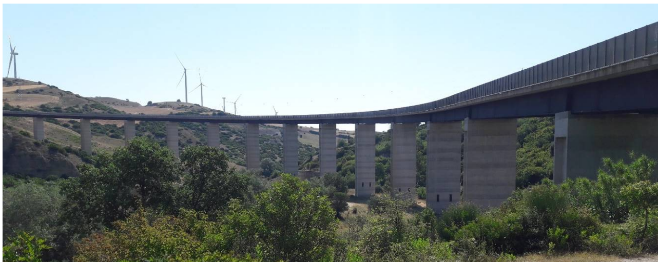
Figura 2.1 Vista dell'opera dalla spalla Sud
