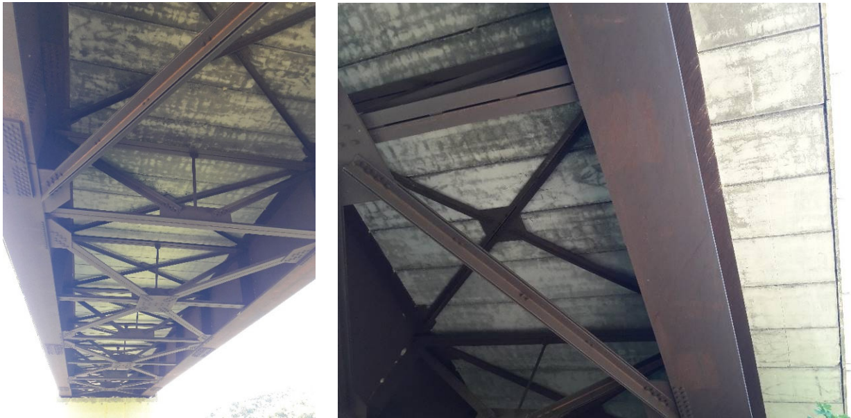
Figura 2.3 Dettagli impalcato a sezione mista acciaio-calcestruzzo
