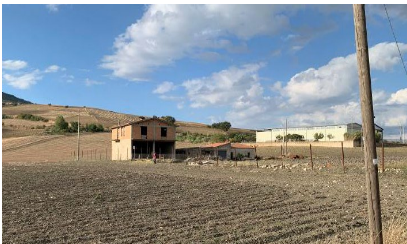
Figura 2-53: esempi dell'edificato nelle aree extraurbane lungo l'itinerario in progetto
