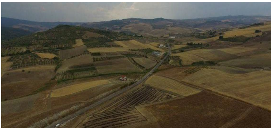
Figura 2-48 – Vista delle aree agricole con edifici sparsi lungo la SP 123, nel tratto nord dell'intervento. Nelle aree collinari si evidenziano le colture a uliveti, mentre le zone pianeggianti sono per lo più adibite a seminativo.
