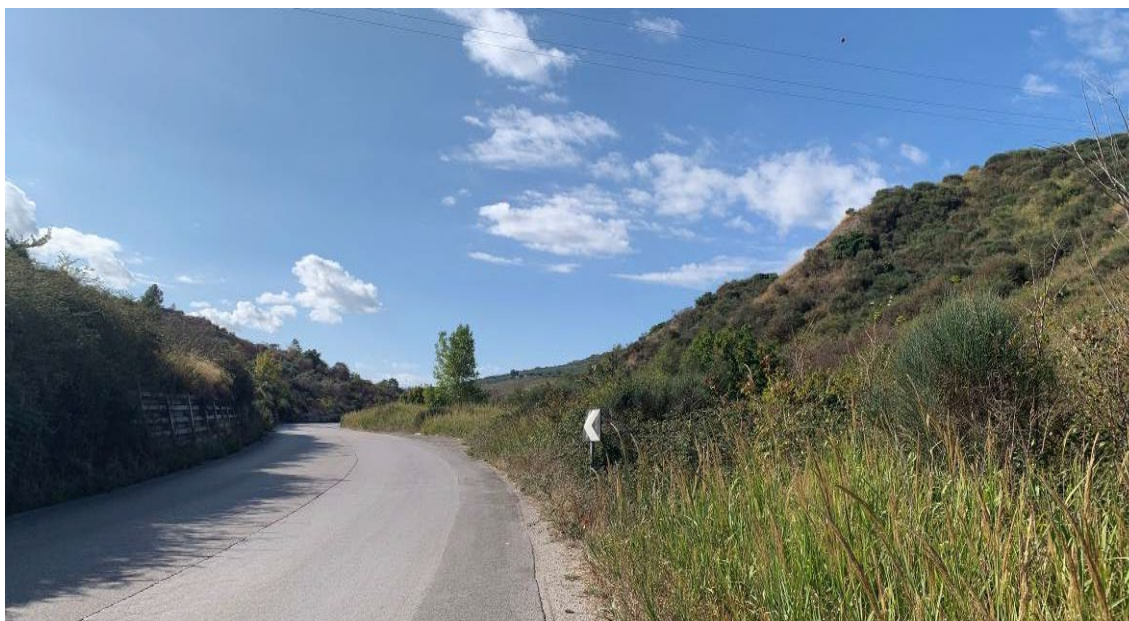
Figura 2-73: una vista del tratto di SP123 in adeguamento
