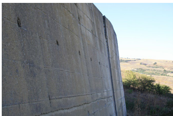
Figura 2.37 – Immagine del muro di contenimento della strada comunale esistente con presenza di un evidente “rotazione” del III concio verso valle per circa 10 cm, a dimostrazione di un dissesto in atto agente sul versante.
