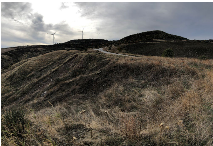
Figura 2.36 – Fenomeni gravitativi attivi agenti lungo il versante interessato dall’opera del Viadotto Cerro e nello specifico dalla Spalla Nord.
