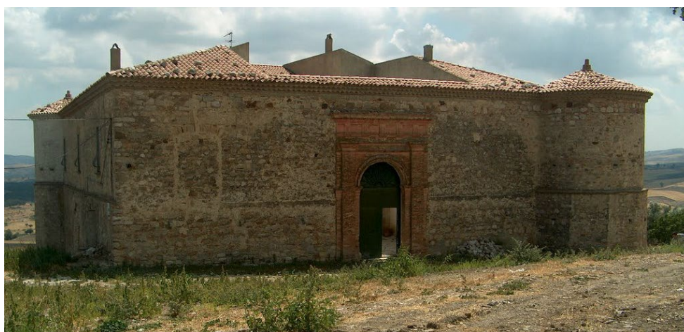
Figura 2-51: Masseria Moles, esempio tipico dell'architettura delle masserie fortificate
