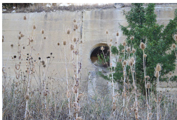
Figura 2.37 – Immagine del muro di contenimento della strada comunale esistente con presenza di un evidente “rotazione” del III concio verso valle per circa 10 cm, a dimostrazione di un dissesto in atto agente sul versante.
