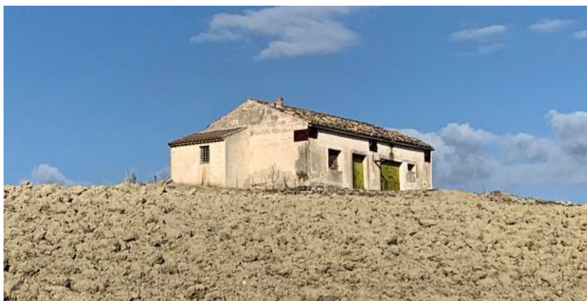
Figura 2-52: esempi dell'edificato nelle aree extraurbane lungo l'itinerario in progetto
