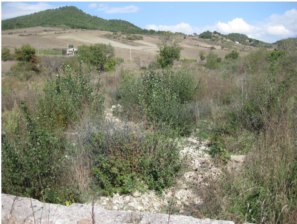
Figura 2.30 – Vallone Tricarico – Tratto a monte dell'attraversamento in progetto
