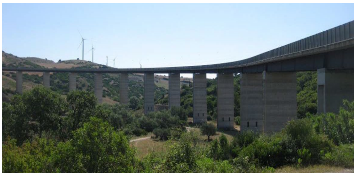
Figura 2-74: vista del Viadotto Girifuolo sulla SP 123
