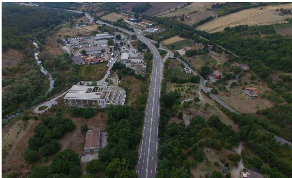
Figura 2-47 – Vista di insediamenti lungo la basentana nell'area di intervento
