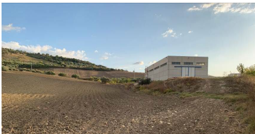
Figura 2-54: esempi dell'edificato nelle aree extraurbane lungo l'itinerario in progetto
