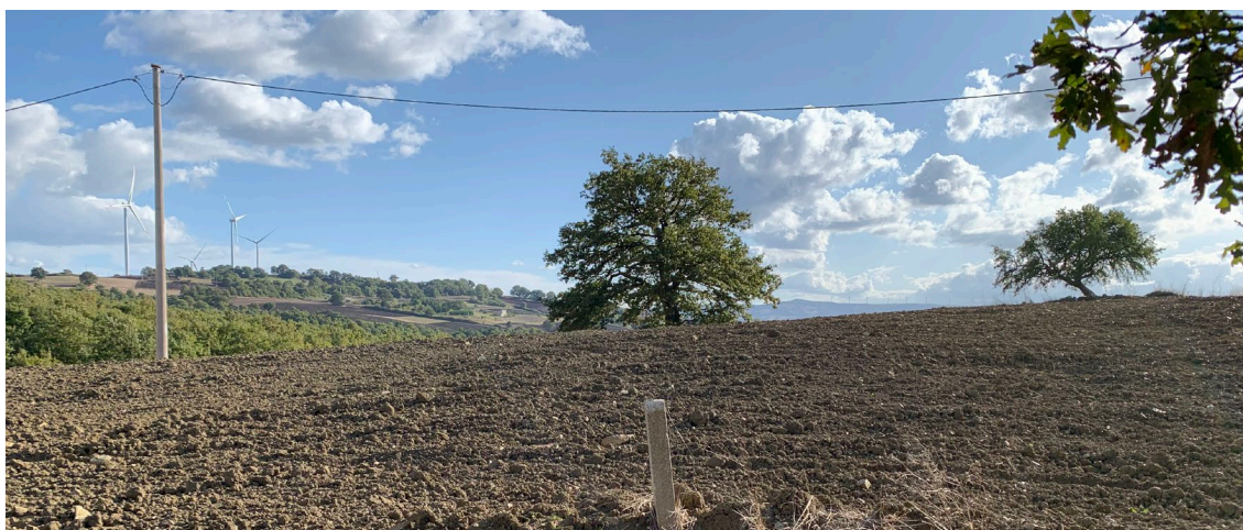
Figura 3-4: veduta dell'area del cantiere dell'imbocco sud della Galleria Pazzano con gli alberi da salvaguardare.
