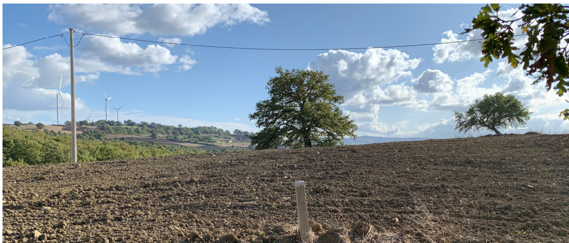
Figura 9.1: veduta dell'area del cantiere dell'imbocco sud della Galleria Pazzano
