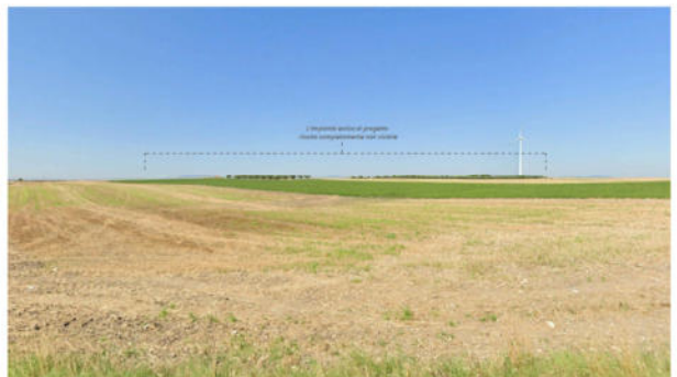
V9 - TRATTURO REGIO BRACCIO POZZO DELLA CAPRE POST OPERAM
