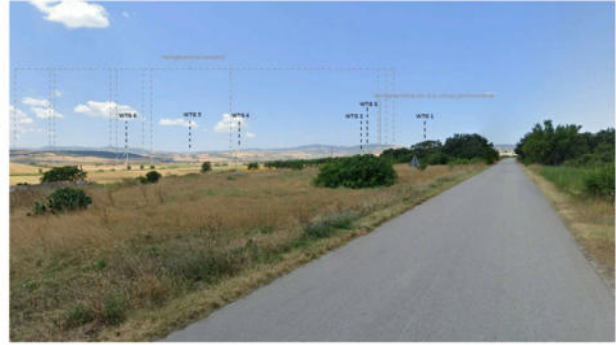
V3 - MASSERIA CIMINO POST OPERAM
