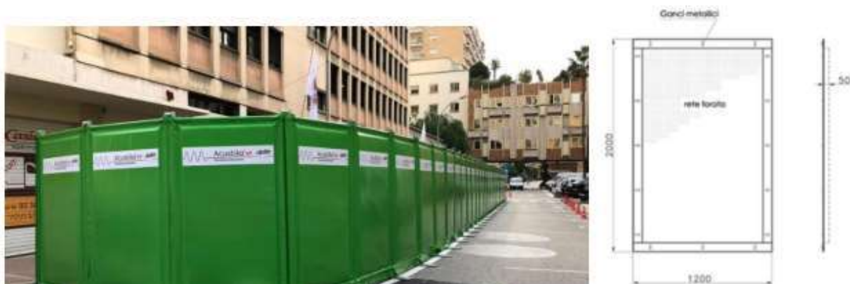
Figura 21 – Caratteristiche esemplificative di una barriera antirumore temporanea
