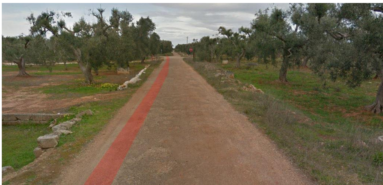
Figura 112 - Fotoinserimento del tracciato del cavidotto con la strada esistente– Interferenza n. 7
