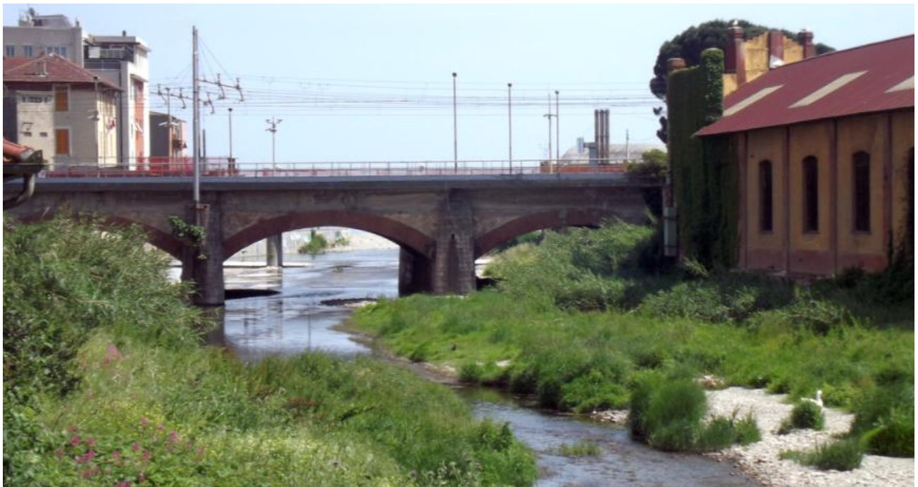
Figura 1: Attraversamento ferroviario esistente sul Torrente Pora.
