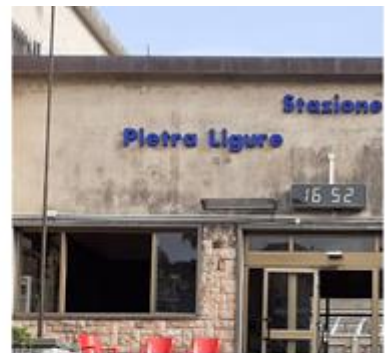
CORNICIONE RIVESTITO IN RAME
