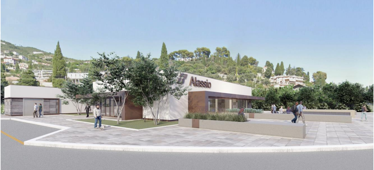
Vista di insieme del piazzale e del fabbricato viaggiatori e tecnologico dell'uscita su via Gastaldi
