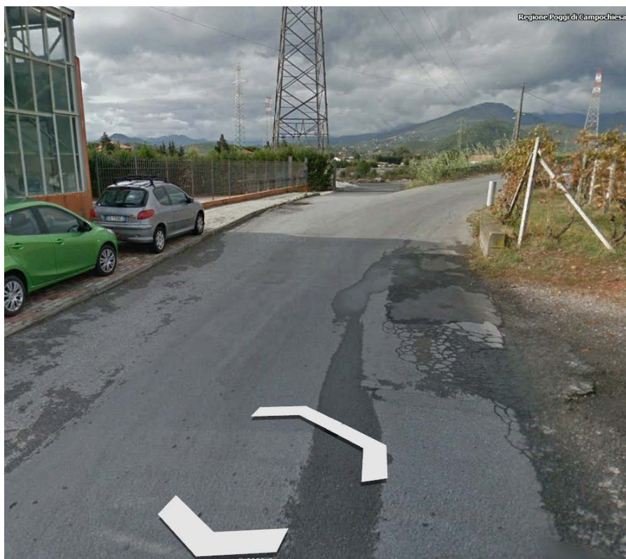
Figura 2 - Stato di fatto
