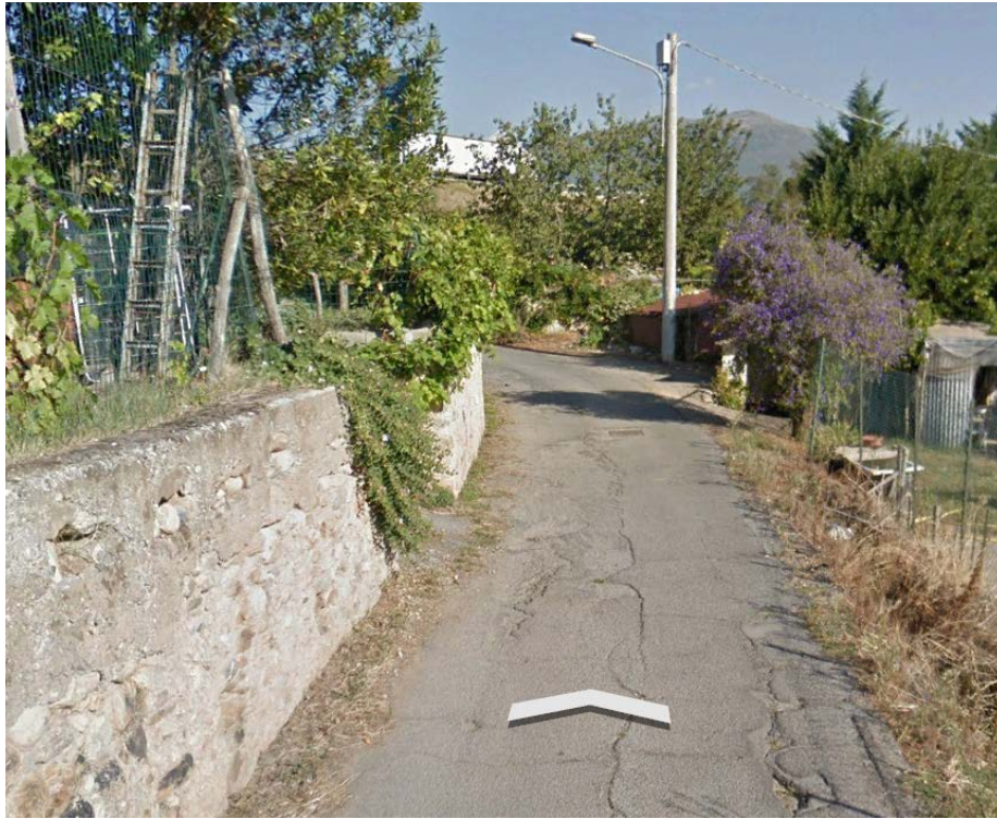
Figura 2 - Stato di fatto
