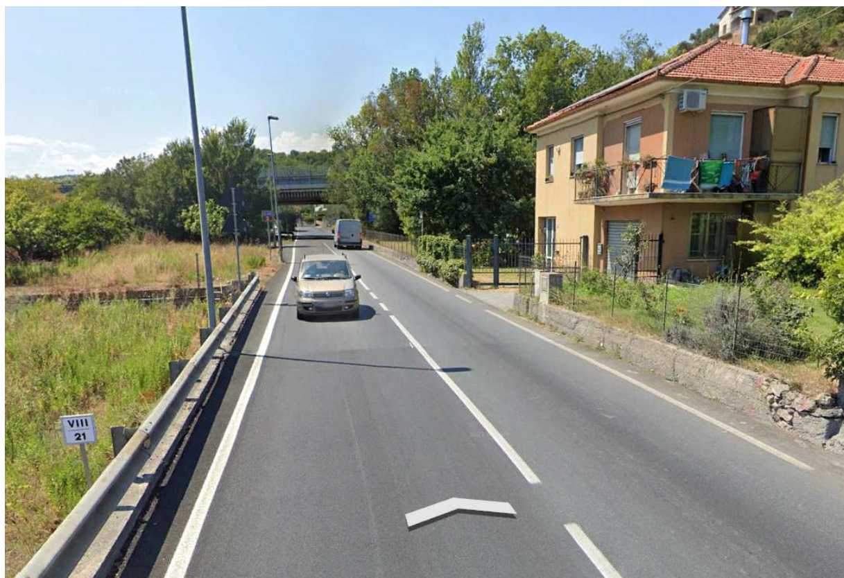
Figura 2 - Stato di fatto
