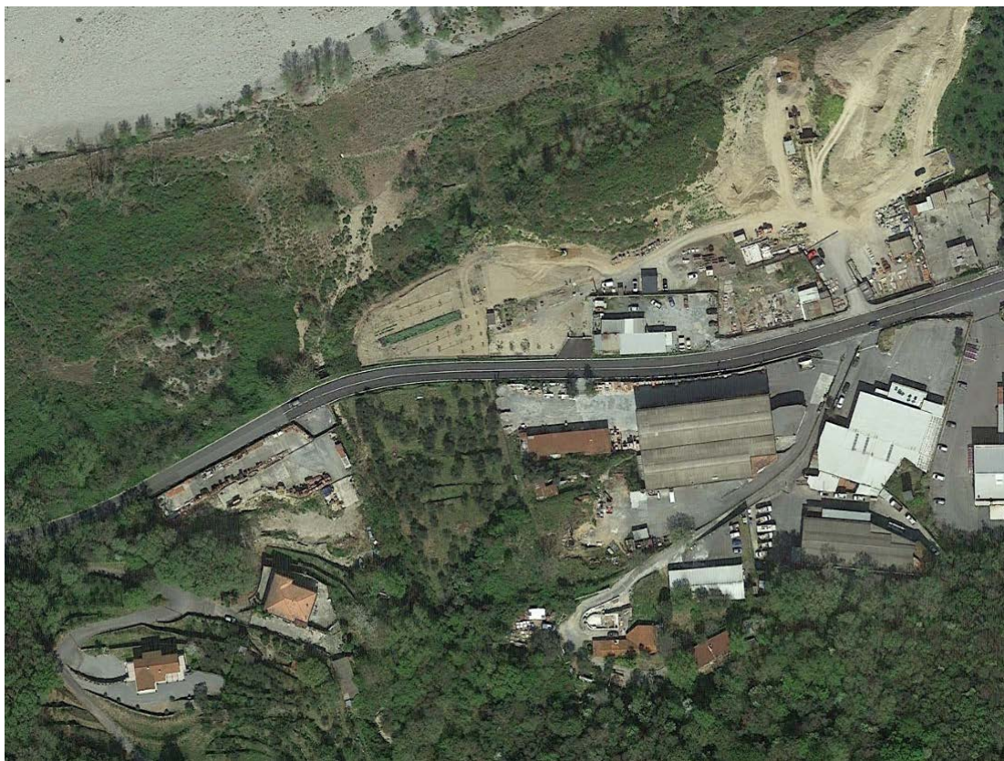
Figura 1 - Stato di fatto - Vista dall'alto
