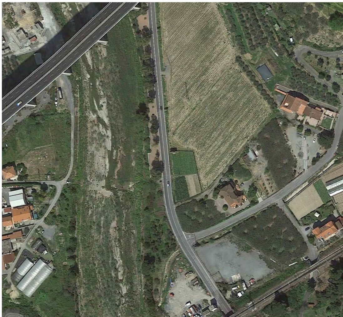
Figura 1 - Stato di fatto - Vista dall'alto
