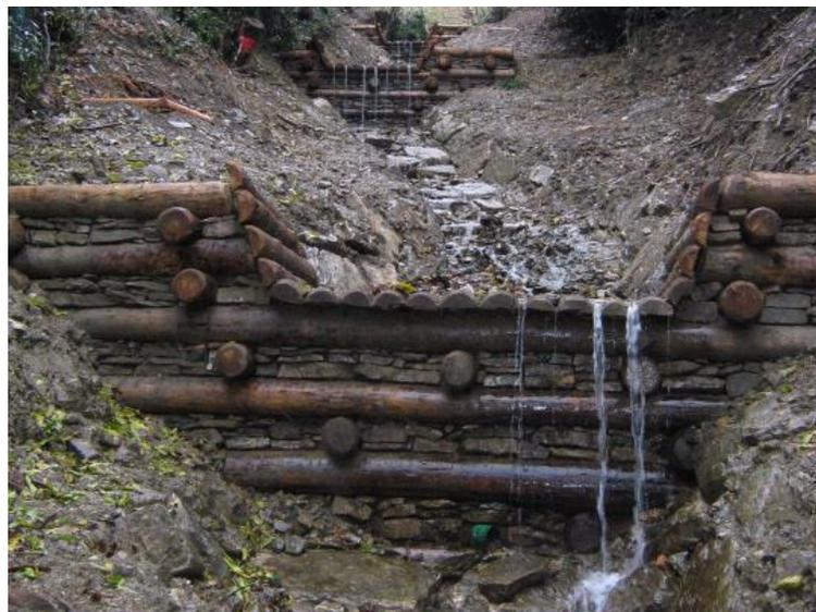
*Figura 30 – Esempio di realizzazione di una briglia in pietrame e legname.*
