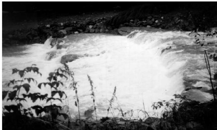
*Figura 31 – Esempio di funzionamento di una rampa in massi durante un evento di piena.*
