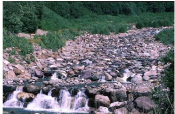
*Figura 30– Esempi di realizzazione di una rampa in massi.*
