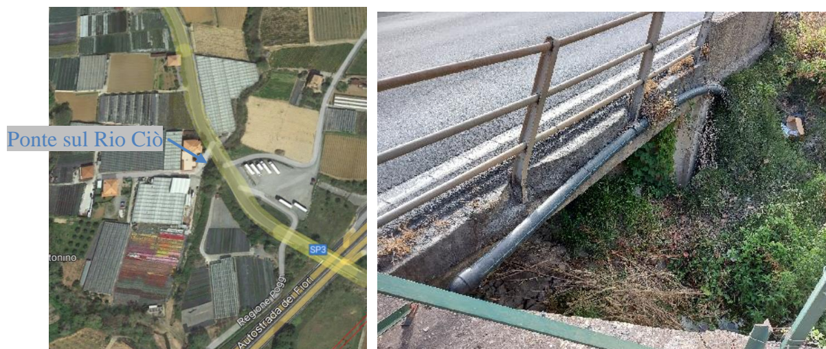
Figura 4: Ponte sul Rio dei Ciò – Ubicazione e fotografia stato di fatto 2021
