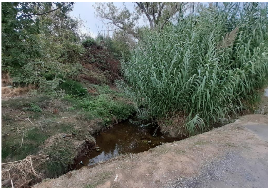
Figura 30: Fotografia da sopralluogo Ottobre 2021 in corrispondenza dell'attraversamento del Carenda con la Strada Regione Carenda Superiore – Vista monte
