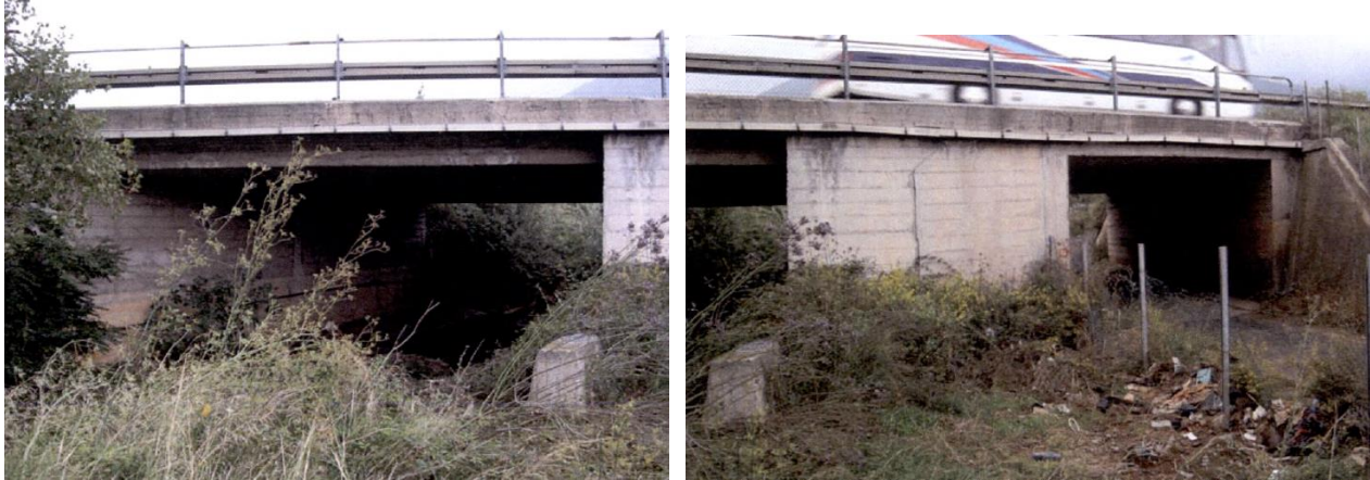
Figura 6: Ponte dell'autostrada A10 sul Torrente Carenda–Fotografia 2010 – rif. B010_L37100D11RIID0002008A
