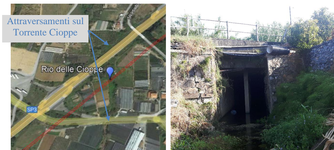
Figura 7: Ponte dell'autostrada A10 sul Torrente Cioppe–Fotografia 2021 del ponte sulla SP3
