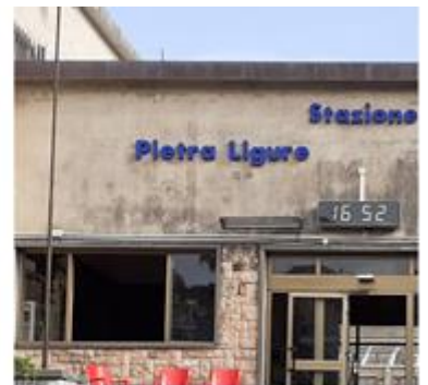
CORNICIONE RIVESTITO IN RAME
