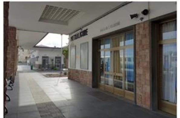
IMBOTTI SEGNATI CON PIETRA SCURA
