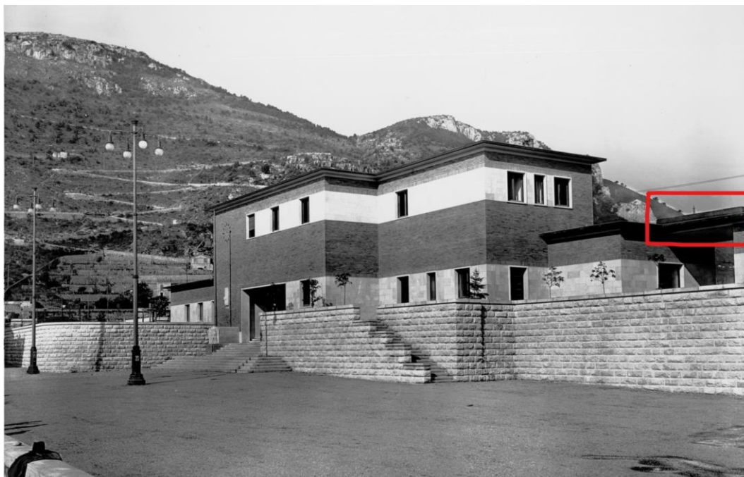
Foto storica con evidenziato il varco che viene riaperto
