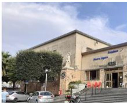
BASAMENTO RIVESTITO IN PIETRA DI FINALE LIGURE
