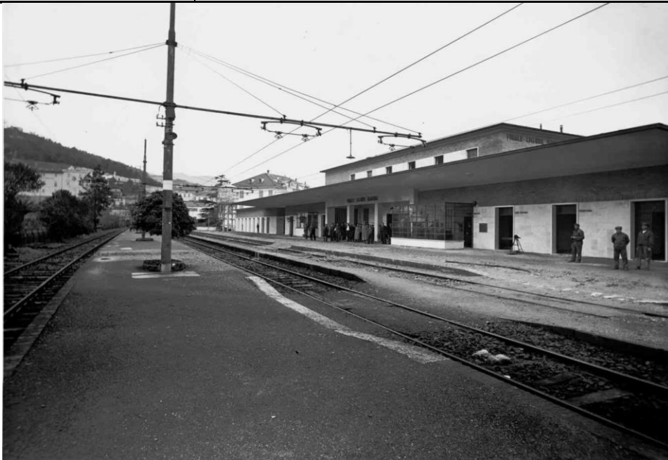
Foto storica con il portico originale che viene riaperto con l'adeguamento banchina
