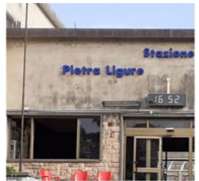
CORNICIONE RIVESTITO IN RAME
