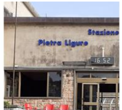
CORNICIONE RIVESTITO IN RAME
