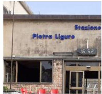
CORNICIONE RIVESTITO IN RAME
