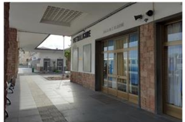
IMBOTTI SEGNATI CON PIETRA SCURA
