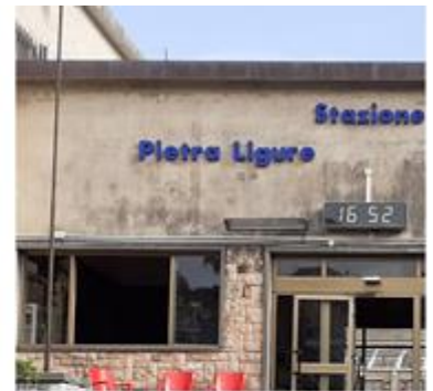
CORNICIONE RIVESTITO IN RAME
