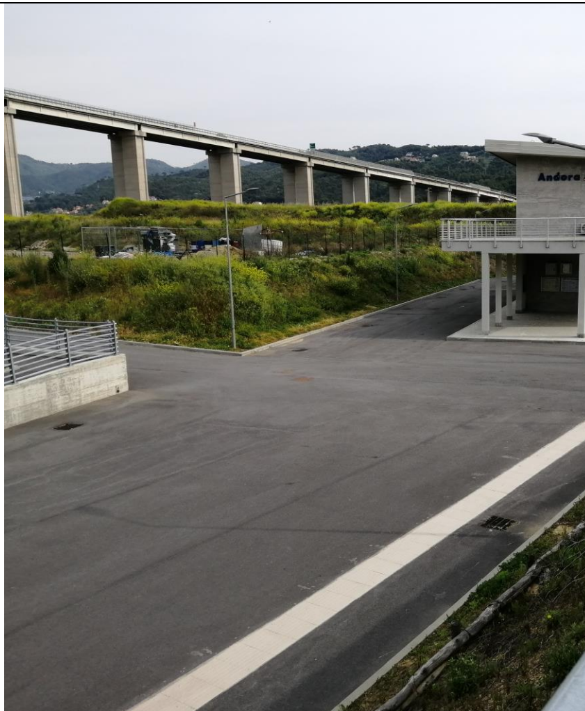
Vista del Cantiere Armamento AR.02.
