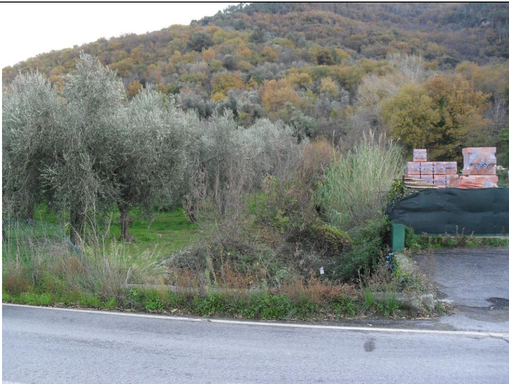
Vista del Cantiere operativo CO.07.
