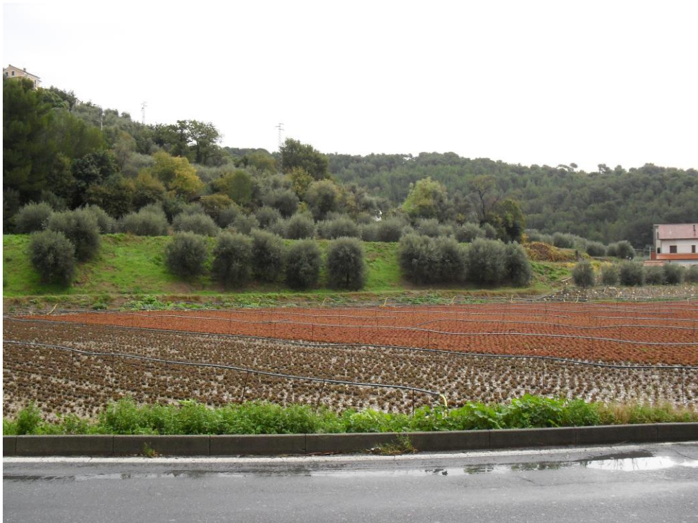
Vista del Cantiere operativo CO.08.
