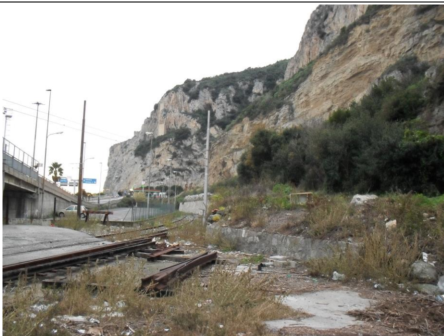
Vista del Cantiere operativo CO.01.
