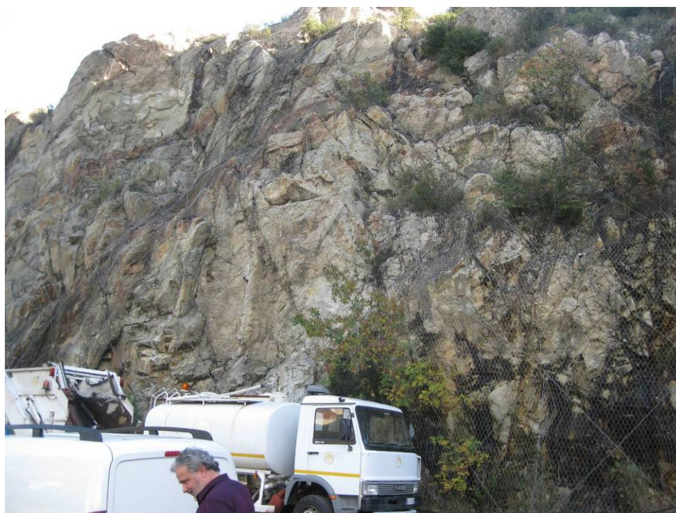
Figura 5.3 Particolare della parete di via Lodi
