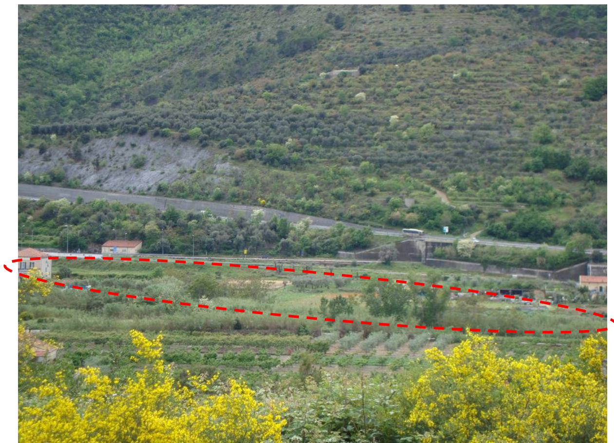
Figura 6.1 Vista dell’area sulla quale insisterà il tracciato in progetto
