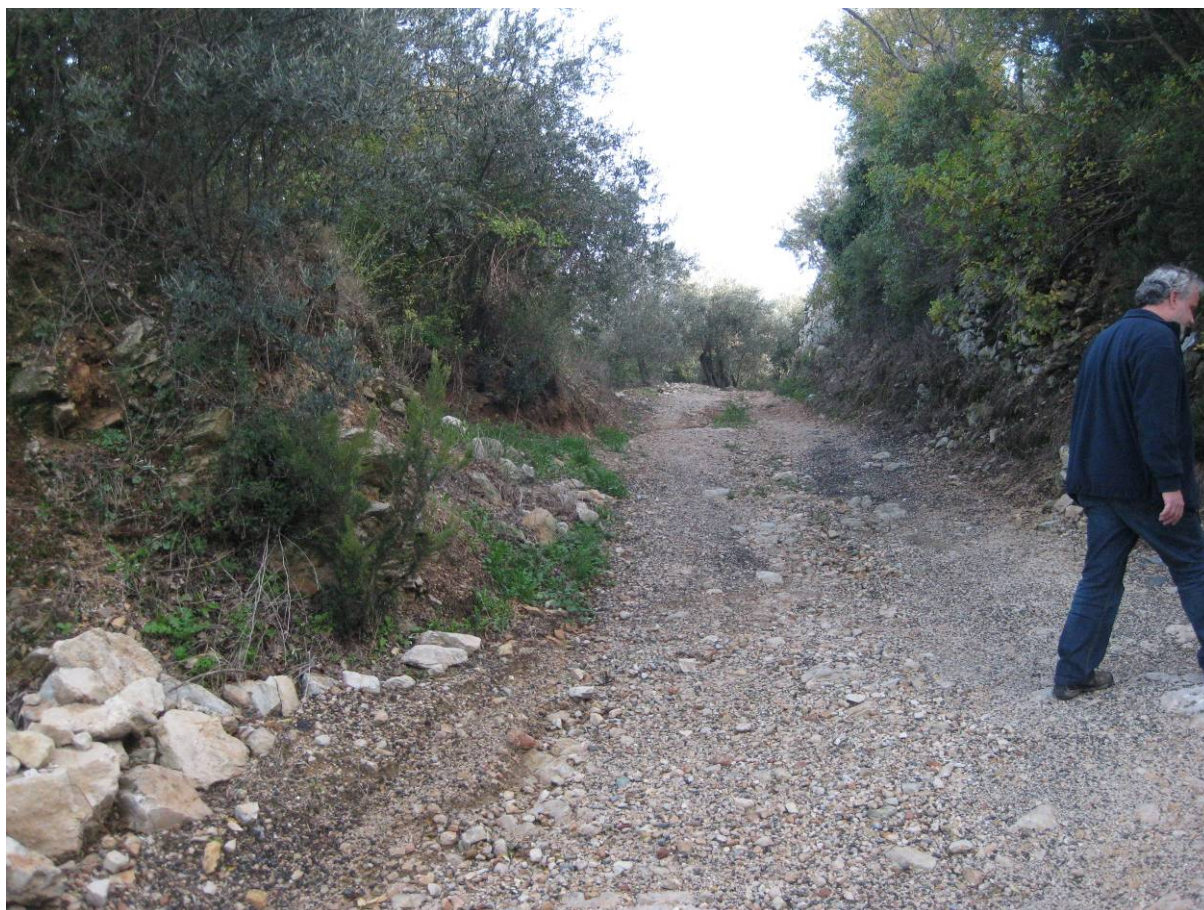
Figura 5.1 Particolare della viabilità esistente di via Lodi
