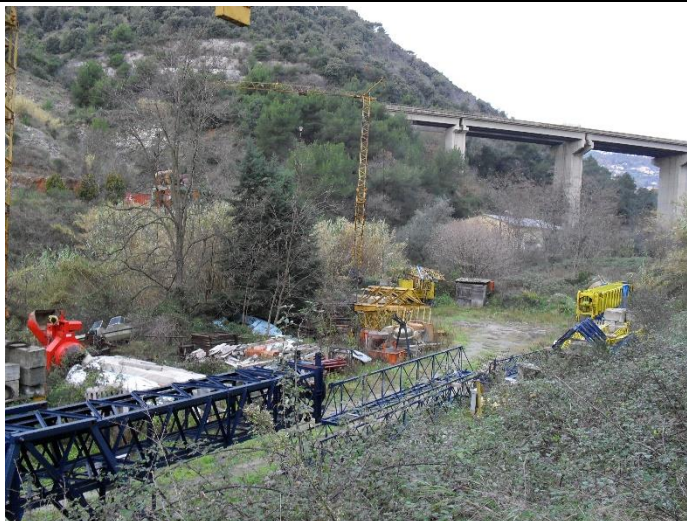
Vista dell'area destinata al cantiere base CB01.
