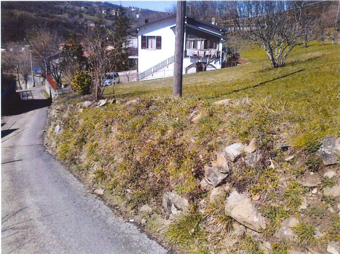
Figura 5-1: vista dei muri in pietra esistenti da ripristinare.
