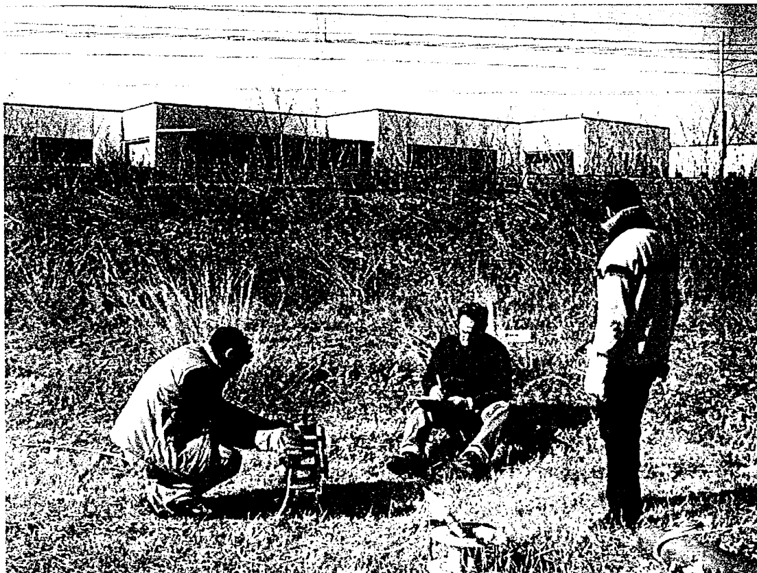
Postazione saggio penetrometrico
