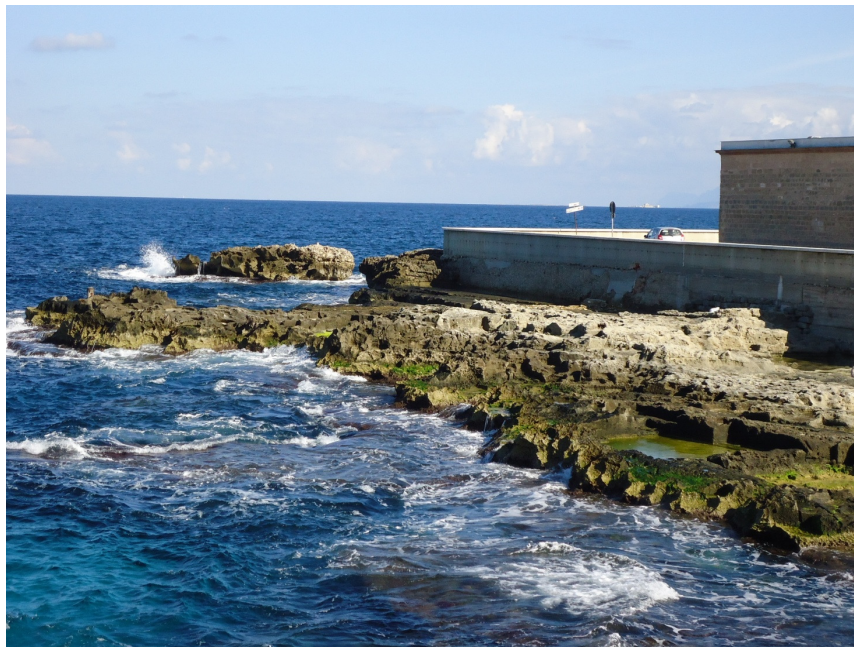
Sito d'intervento – stato dei luoghi
