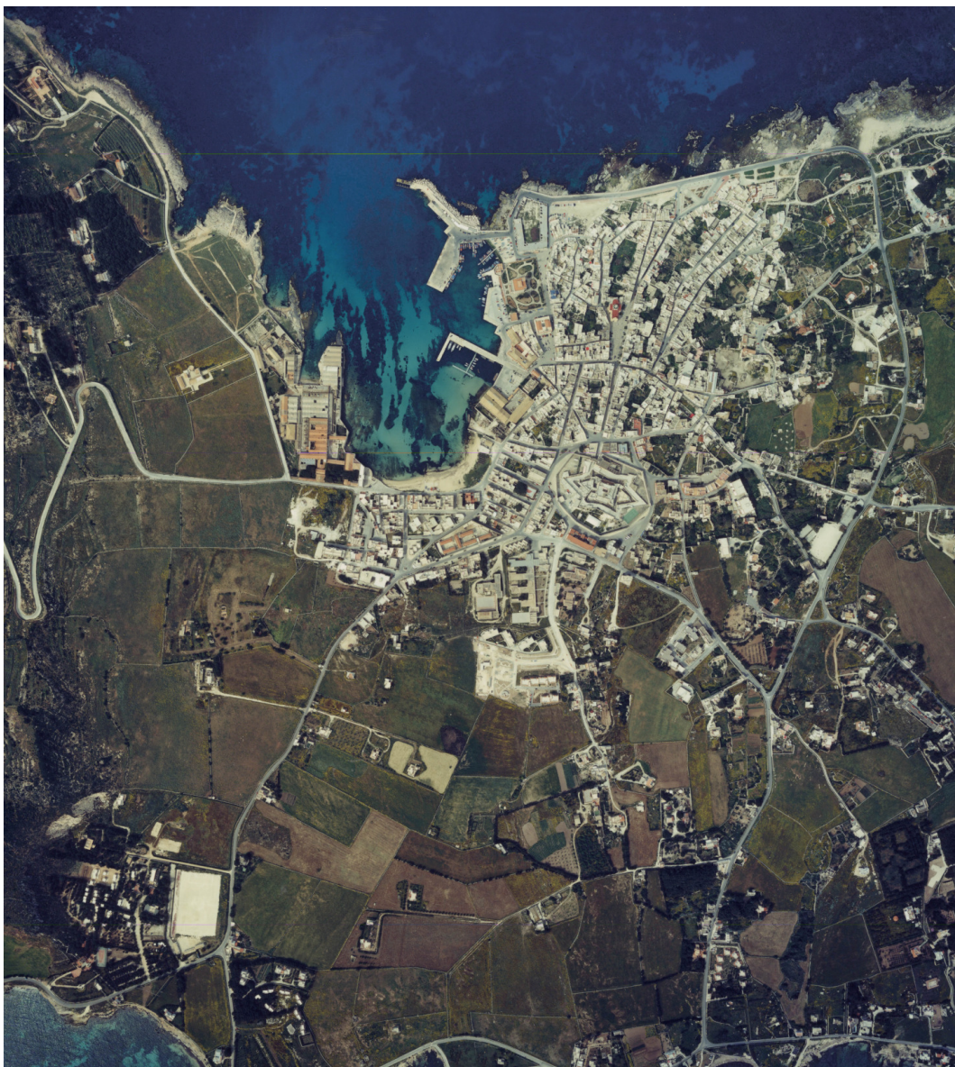
Vista aerea del porto di Favignana (Cala Principale)
