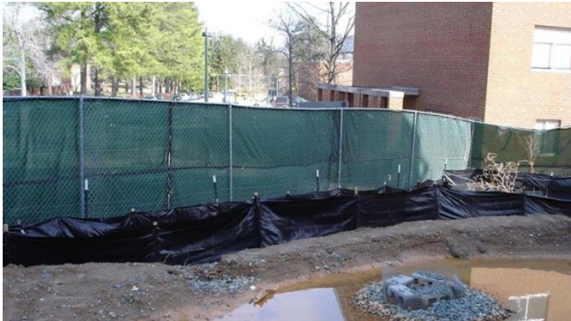
Contenimento dei sedimenti nell'area di cantiere
