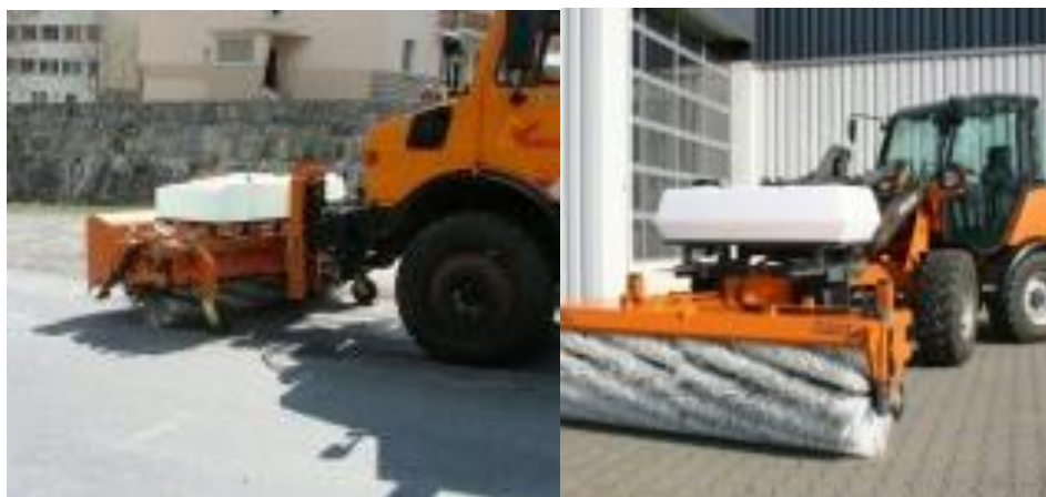
Spazzolatura della viabilità esterna al cantiere interessata dal traffico dei mezzi di cantiere
