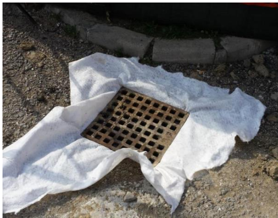
Protezione tombino con geotessile
