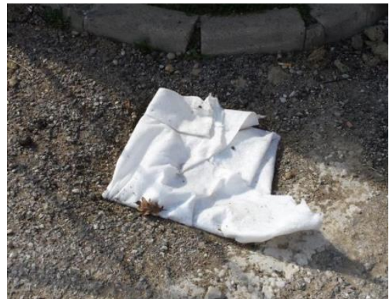
Protezione tombino con geotessile
