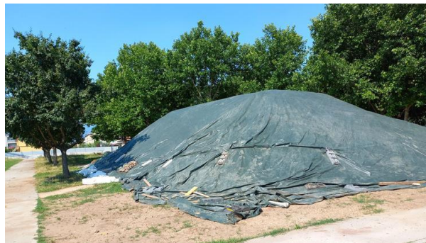
Copertura cumulo in terra con telo di protezione antierosivo
