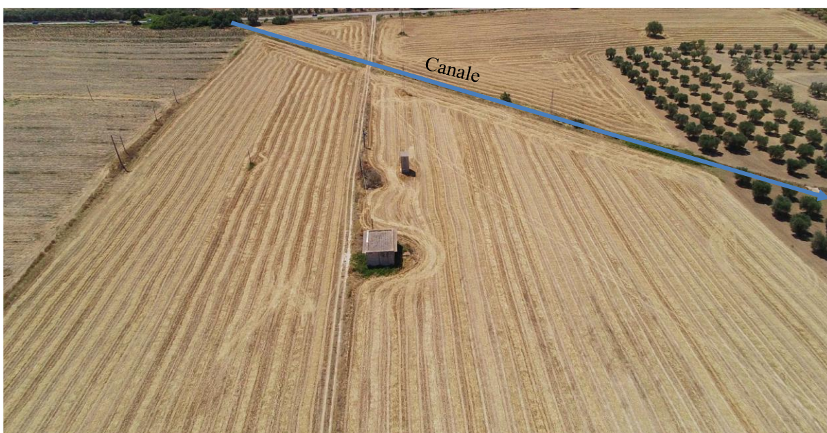
Fig. 2 – Attraversamento del canale - Area A
