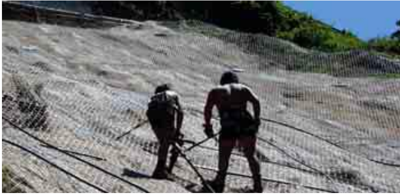
Fig. 7 – Esempio di rivestimento vegetativo durante la posa
