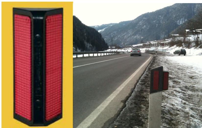
Figura C.4-20 – Dissuasori ottici – esempio realizzato lungo la SS 49 della Pusteria (provincia di Bolzano)
