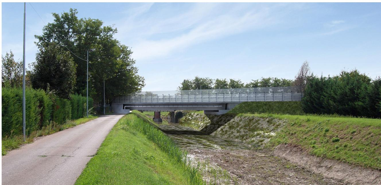
Figura C.4-33 Esempio di protezioni antifoniche trasparenti, ponte sul torrente Modolena
