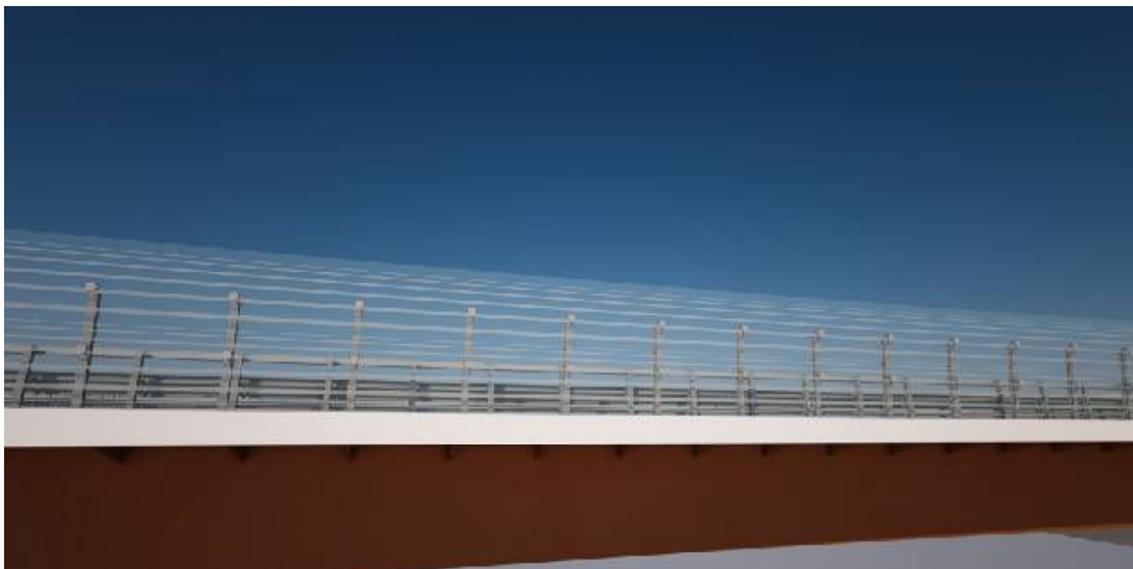
Figura C.4-32 - Esempio di protezioni antifoniche trasparenti, Viadotto sul fiume Crostolo
