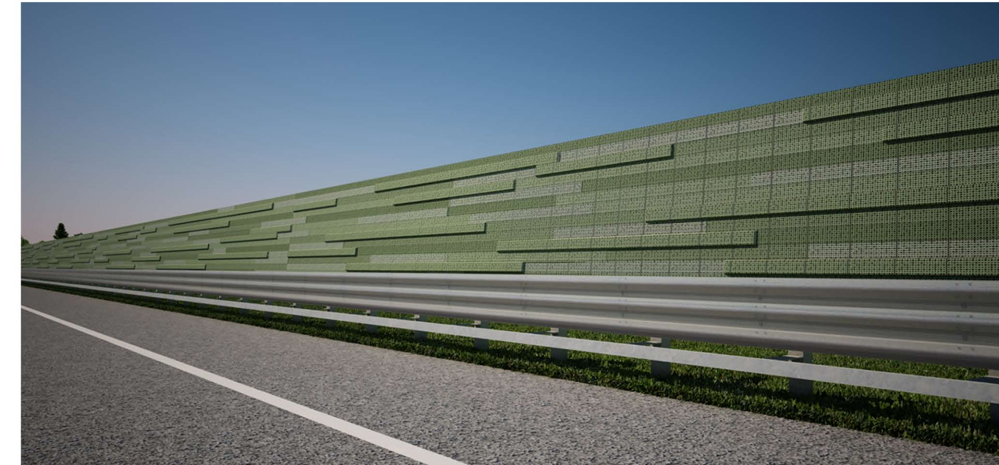
PROTEZIONE ANTIFONICA BIDIMENSIONALE SU VIADOTTO: SIMULAZIONE DI DETTAGLIO LATO SORGENTE (TRATTO DI TRANSIZIONE)
