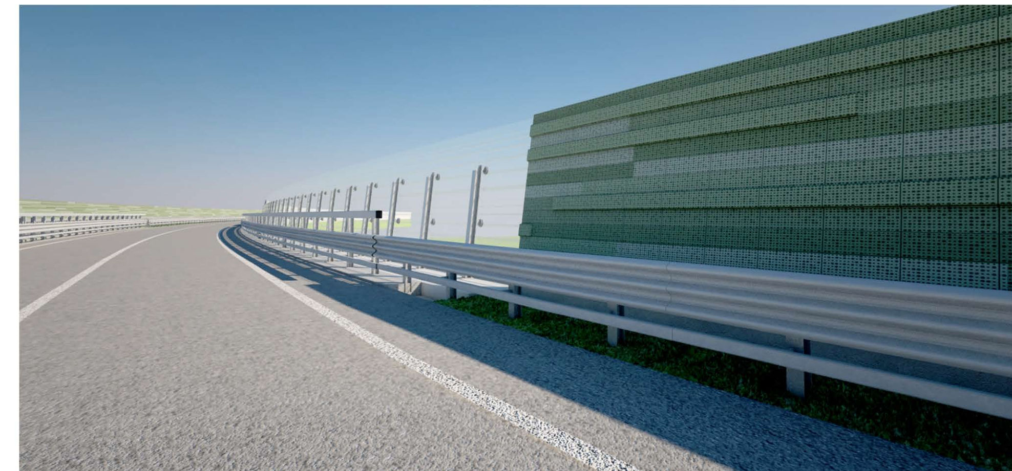
PROTEZIONE ANTIFONICA BIDIMENSIONALE SU VIADOTTO: SIMULAZIONE DI DETTAGLIO LATO SORGENTE (TRATTO DI TRANSIZIONE)
