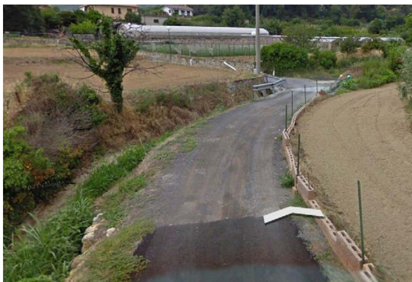
Figura 3 - Stato di fatto
